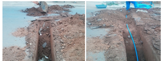
Figura 4. Execução de vala para extensão de ramal pelo método destrutivo.
