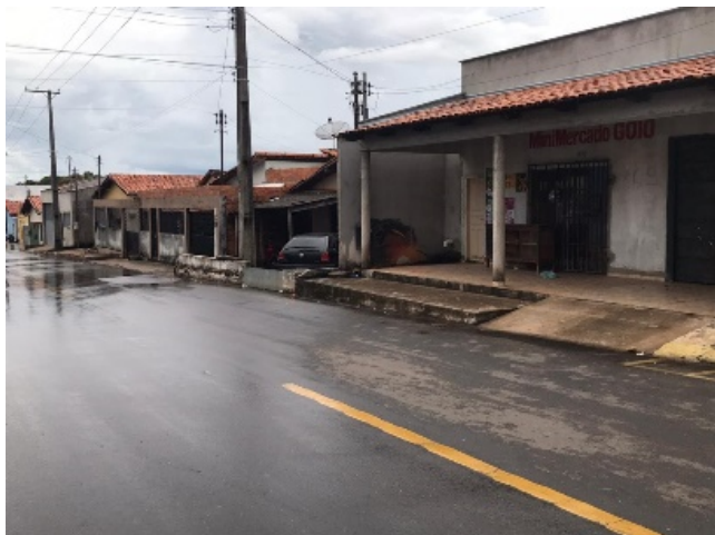
Figura 3. Falta de Padronização e Acessibilidade Nas Calçadas.
