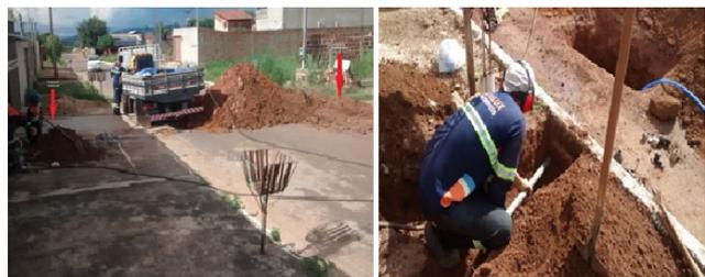
Figura 5. Método não destrutivo de execução de ramais de ligação.
