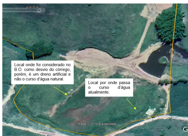
Figura 5. Detalhe da trajetória da água após a ampliação da lâmina d'água do açude e elevação do barramento. Fonte: Software Google Earth.
