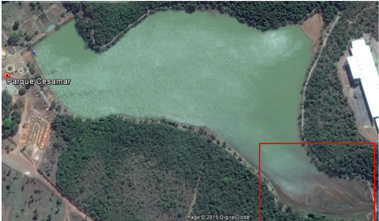
Figura 9 - Parque Cesamar em Julho de 2014 - antes da dragagem
