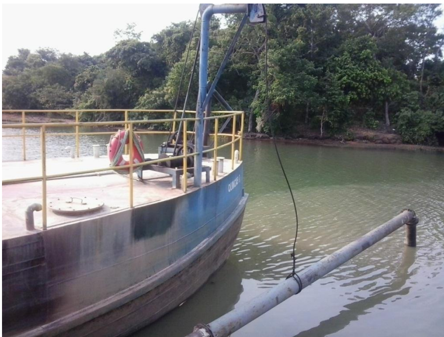
Figura 12: tubulação de sucção. Fonte: Arquivo pessoal (autorizada a divulgação pela empresa)
