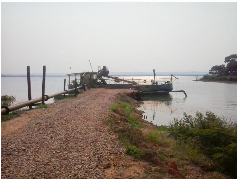
Figura 10: Tubulação na qual leva a Areia e o Seixo até o pátio para o peneiramento. Fonte: Fonte: Arquivo pessoal (autorizada a divulgação pela empresa).
