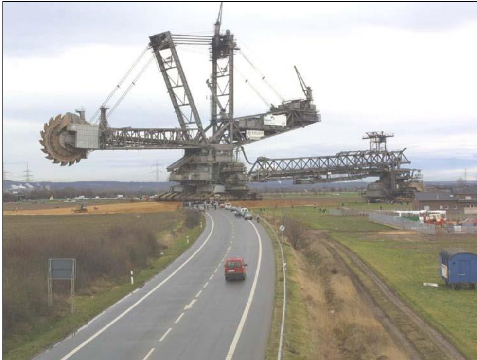
Figura 7: Escavadeira Bucket Wheel, Bagger 288
