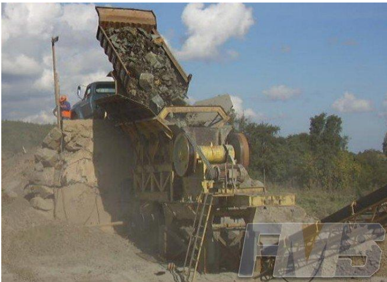
Figura Erro! Indicador não definido. - Britagem Primária Fonte: ( http://pt.trituradoras-de-roca.com/uploads/allimg/131112/1-131112105313931.jpg ).
