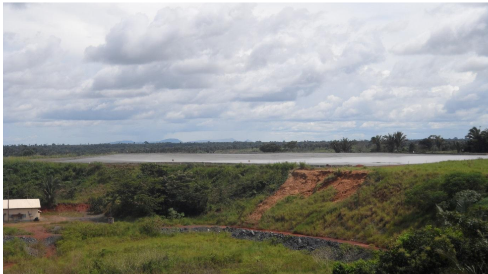
Figura 13: Barragem de Rejeito da Unidade RML.
