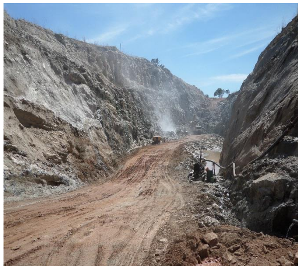
Figura 5: Cava principal – Maio 2014. Fonte: Própria.
