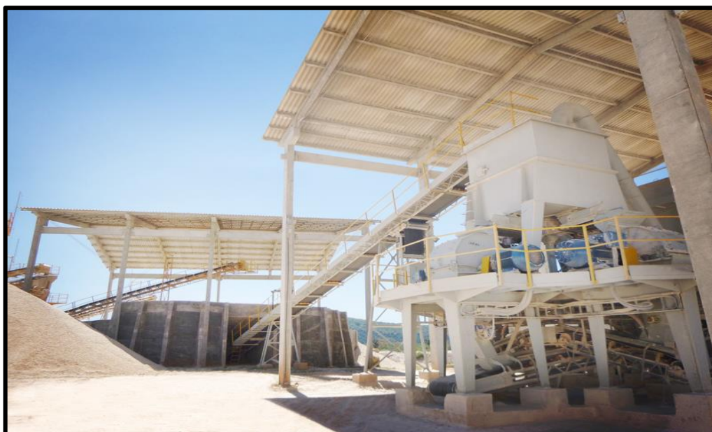
Figura 4 - Estrutura de beneficiamento de minérios da Minerax
