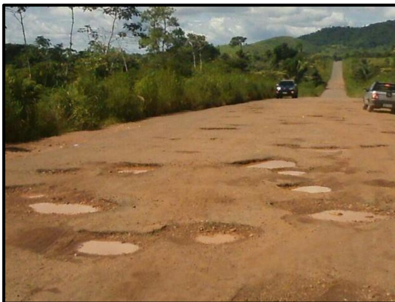
Figura 6 - TO-164 próximo a Xambioá-TO
