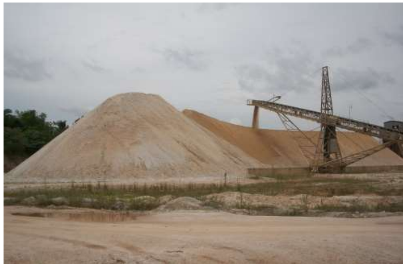
Figura 2: Pátio de pré-homogeneização da Unidade de Xambioá Fonte: Arquivo pessoal, 2013.
