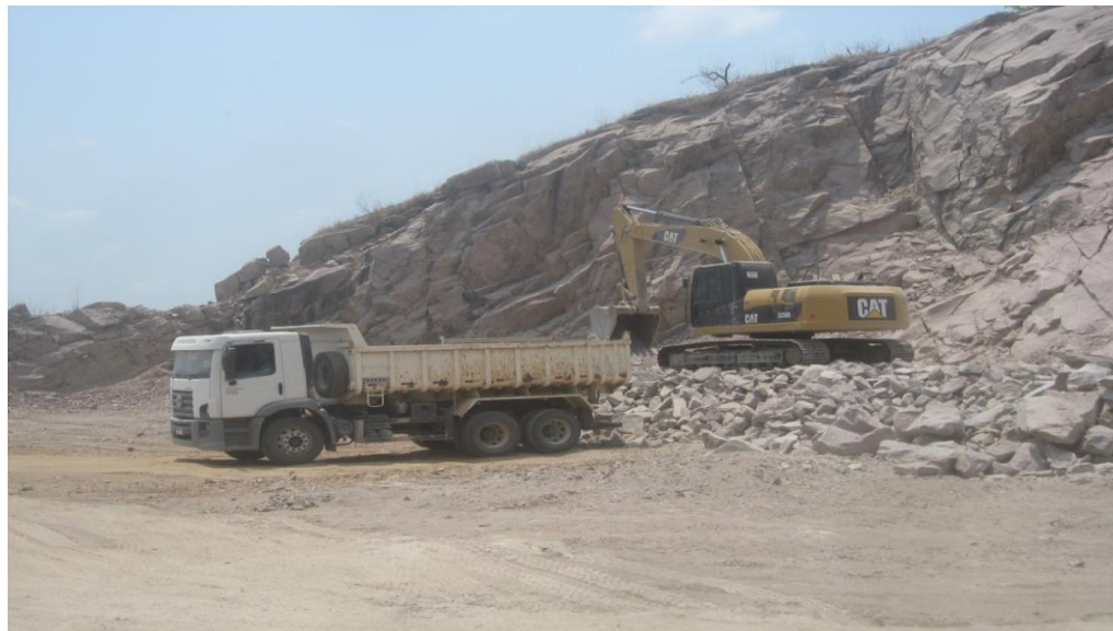
FIGURA 2. carregamento na frente de lavra
