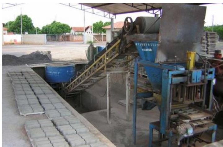
Figura 40: Moldagem dos blocos de concreto.
