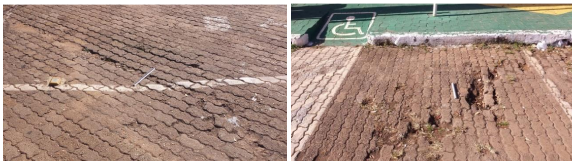
Figura 24: Manifestação patológica por segregação das PPC.
