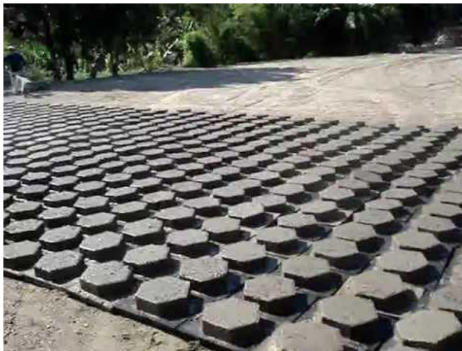
Figura 36: Processo de secagem dos blocos de concreto.
