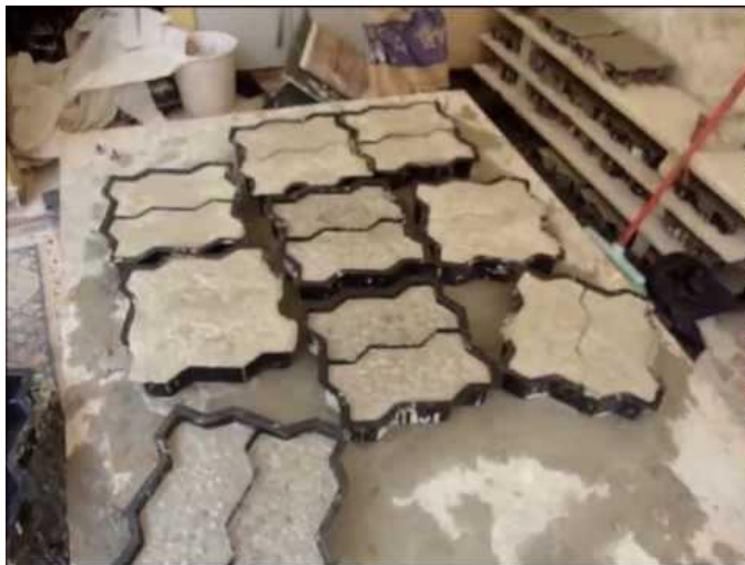
Figura 35: Moldagem dos blocos de concreto.
