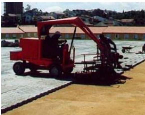
Figura 8: Assentamento mecanizado de PPC.
