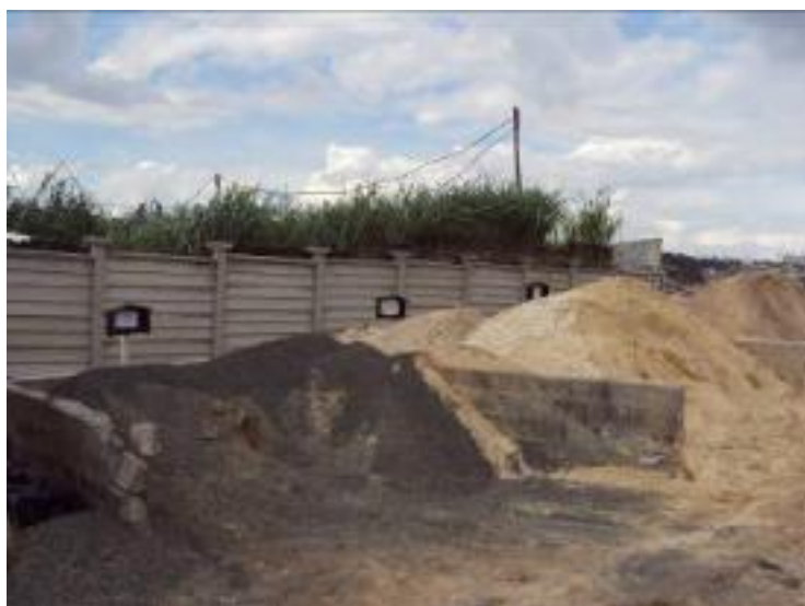
Figura 37: Baias de agregados.
