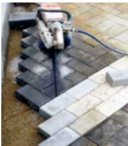
Figura 13: Ajustes e arremates nas peças pré-moldadas de concreto.
