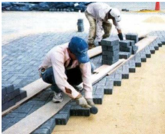
Figura 7: Execução de assentamento dos blocos de concreto.
