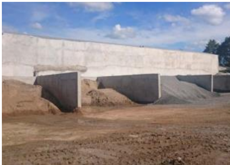
Figura 39: Baias para estocagem de agregados.
