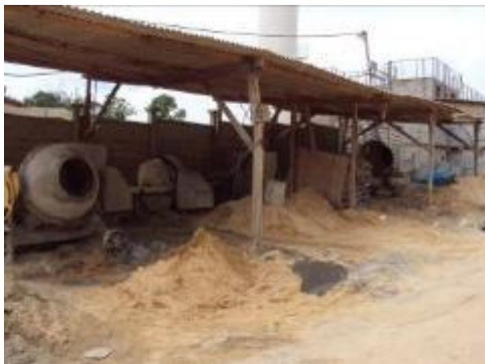
Figura 33: Estocagem dos agregados.
