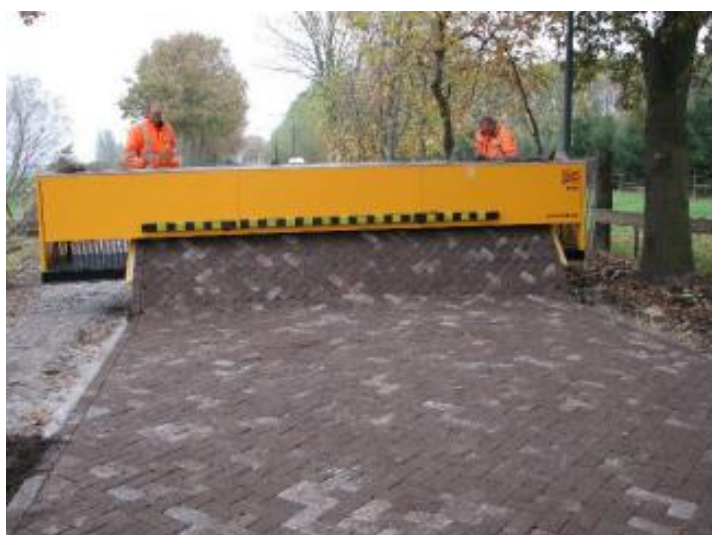
Figura 9: Assentamento mecanizado de PPC utilizado na Holanda.
