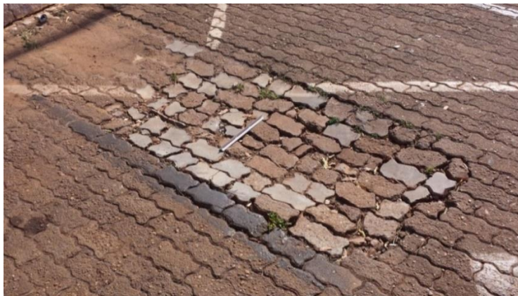
Figura 23: Manifestação patológica por recalque.
