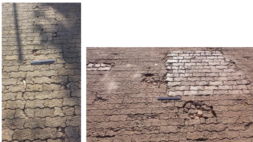
Figura 28: Manifestação patológica por armazenamento dos blocos.
