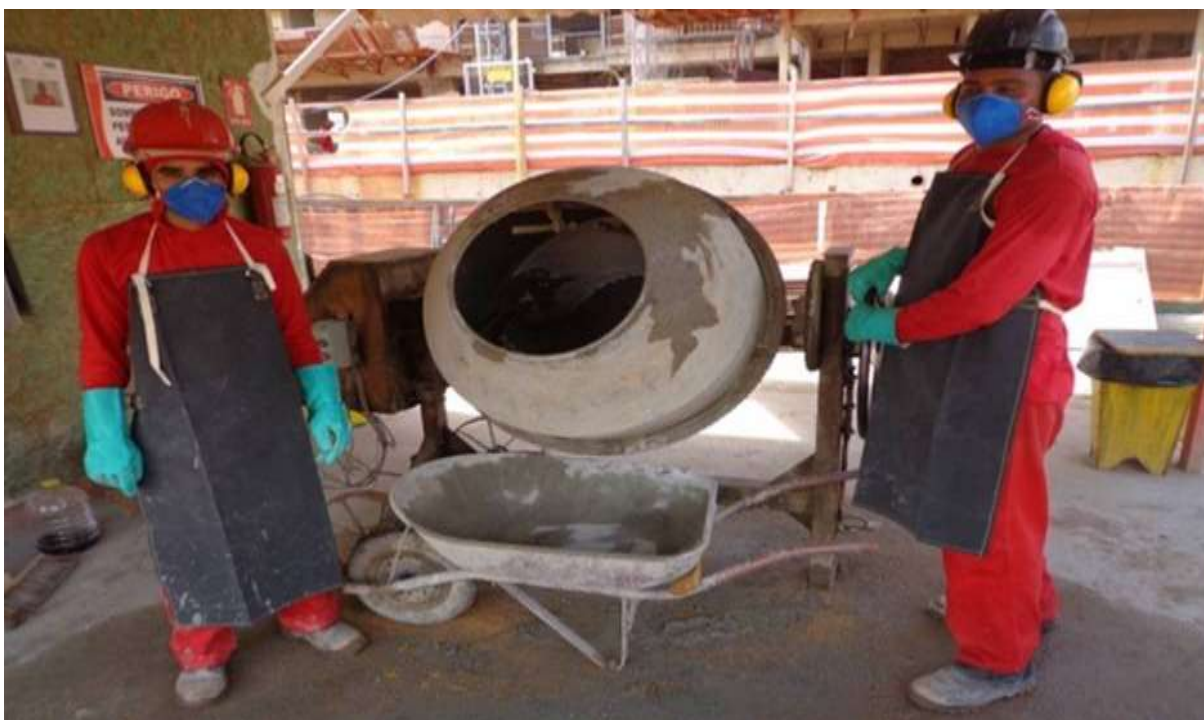
Figura 7: Operação com betoneira
