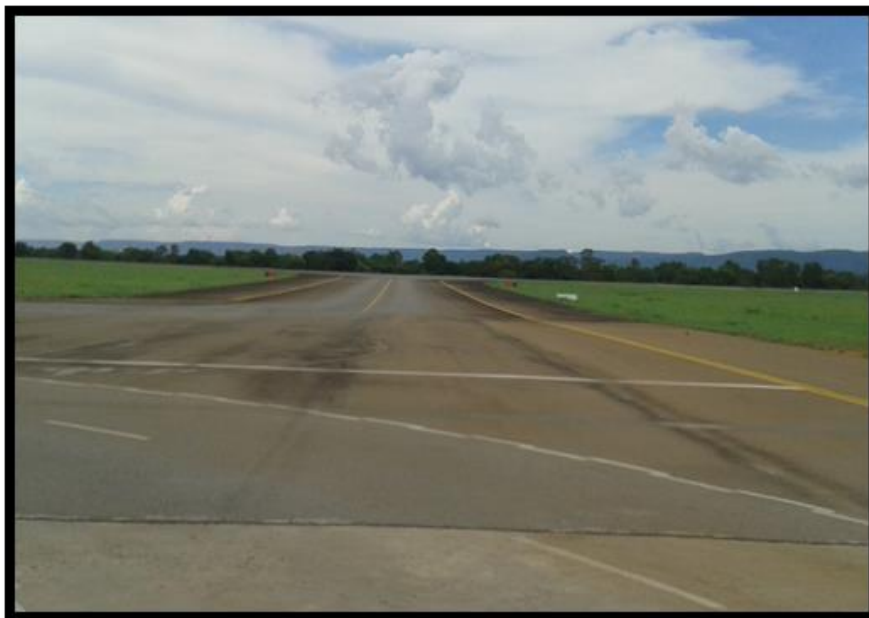
Foto 1 – Zona de acesso à pista de pouso e decolagem.
