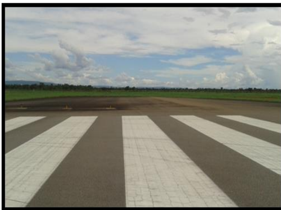
Foto 4 – Zona de parada de aeronaves ( stopways ).
