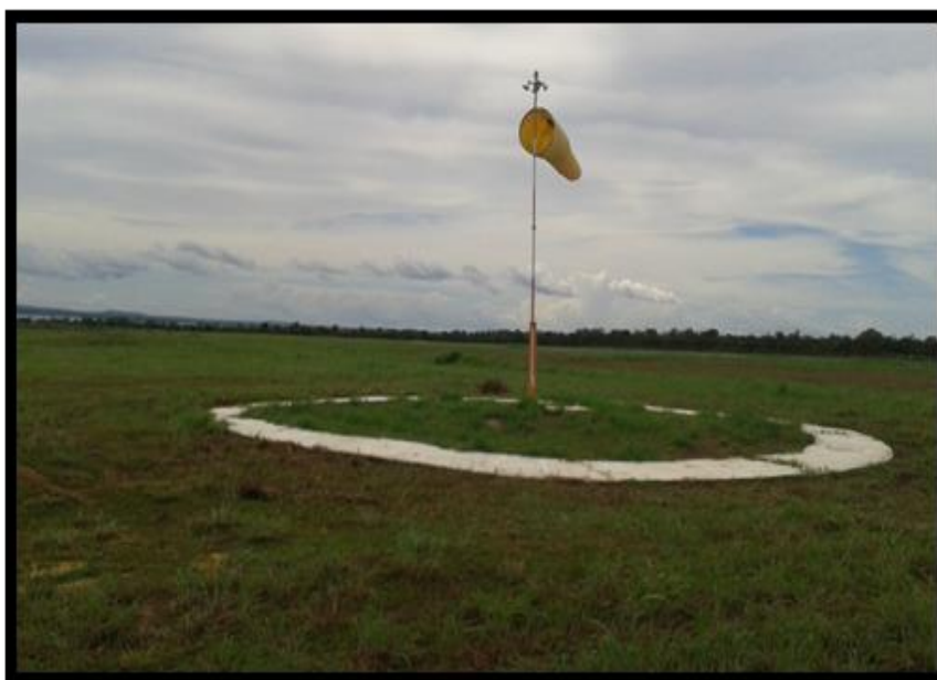
Foto 8 – Dispositivo de indicador de vento (biruta) instalado ao lado da cabeceira 14.
