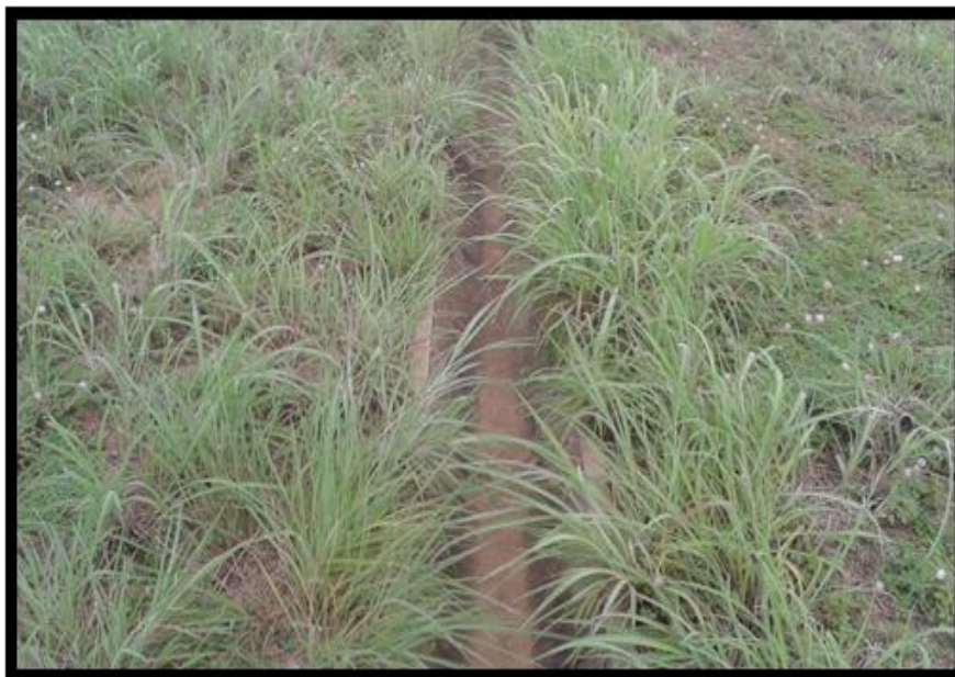
Foto 9 – Dispositivo de drenagem (canal de concreto) construído nos dois lados da pista de pouso e decolagem.
