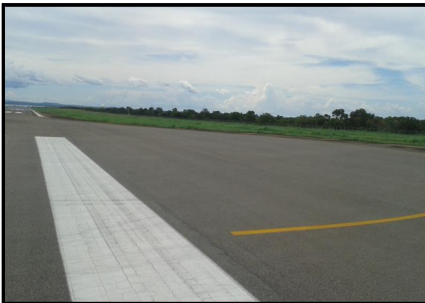
Foto 3 – Alargamento do final da pista para manobra de aeronave.
