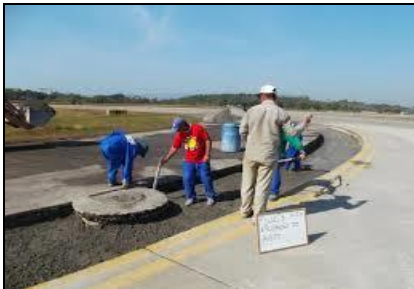
Figura 11 - Execução do alargamento da pista de táxi.
