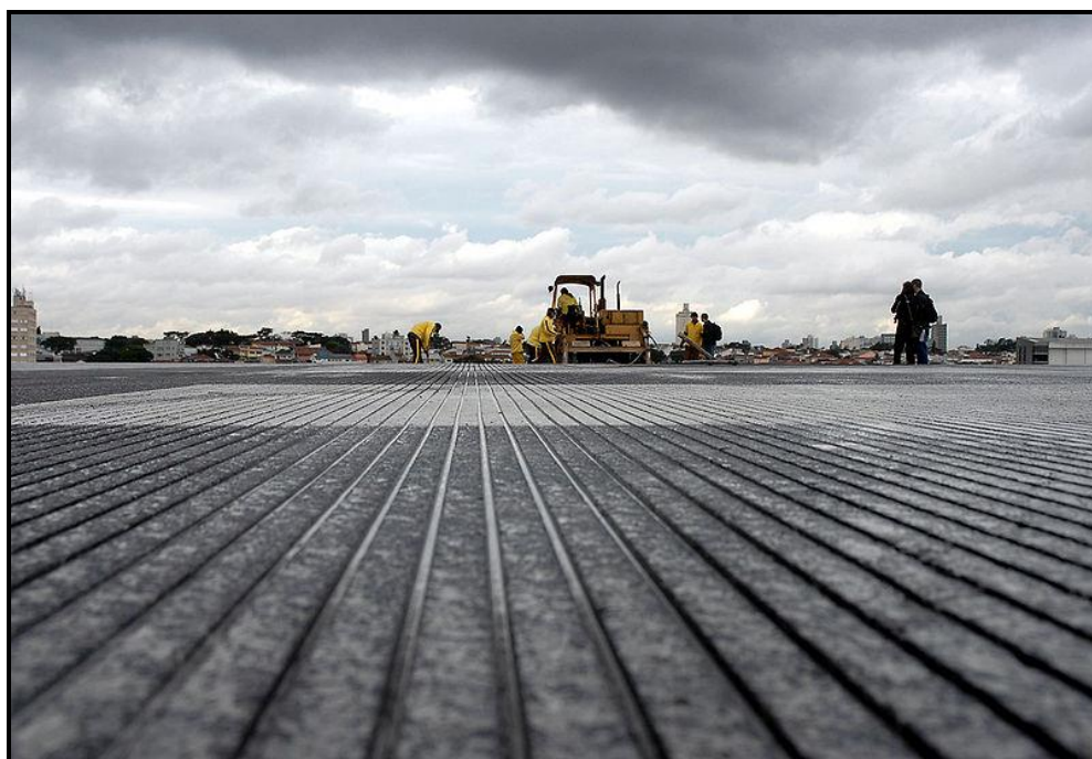
Figura 7 - Grooving na pista de Belém.
