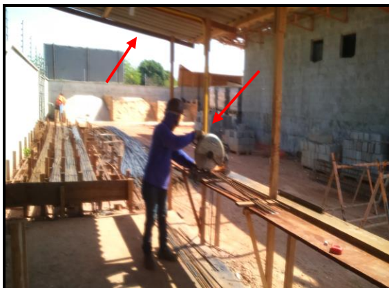
Figura 12: Ferragem, serviços de corte e dobra
