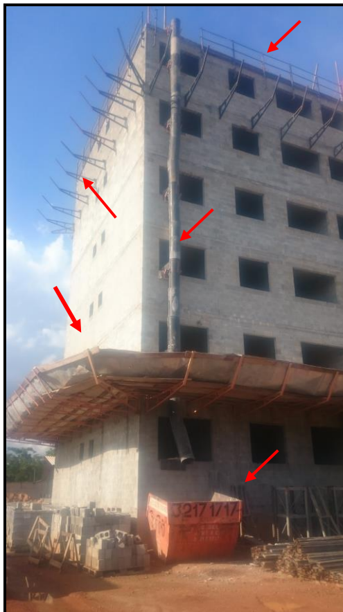
Figura 18: Plataformas e guarda corpo
