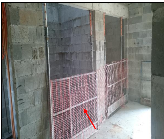
Figura 14: Fechamento Provisório Vão do elevador
