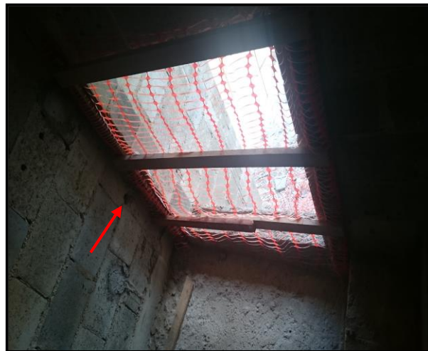
Figura 15: Fechamento Provisório abertura de escada
