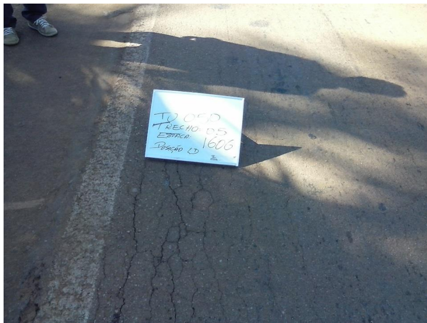
Figura 26 – Trinca longitudinal
