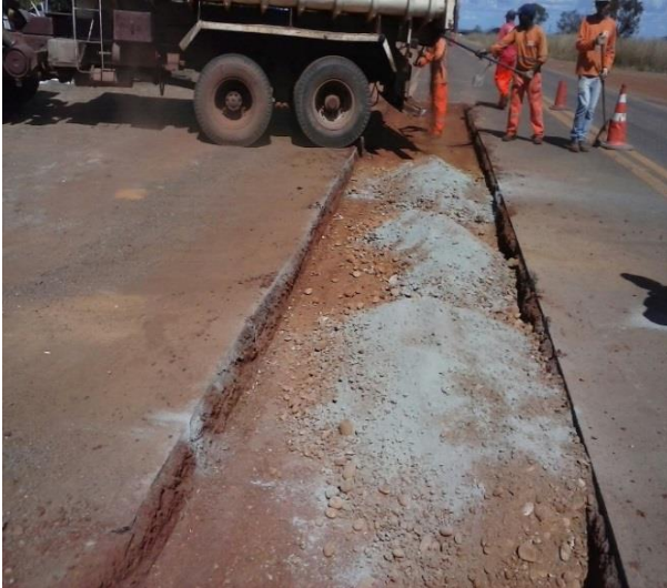
Figura 29 – Solo melhorado com cimento
