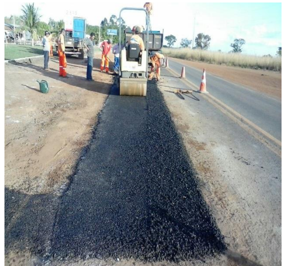
Figura 32 – Compactação do PMF
