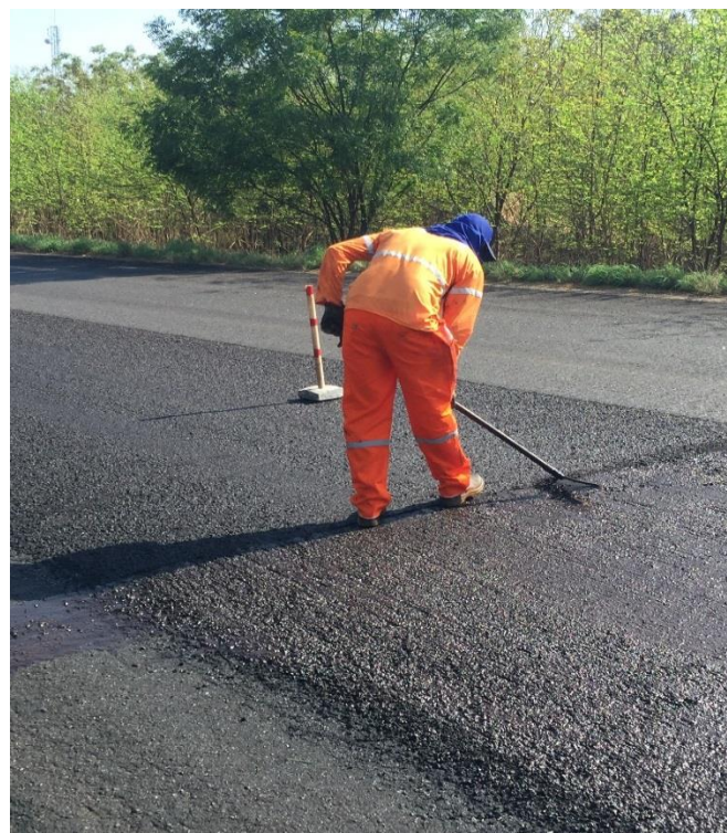
Figura 39 – Conformação de falhas
