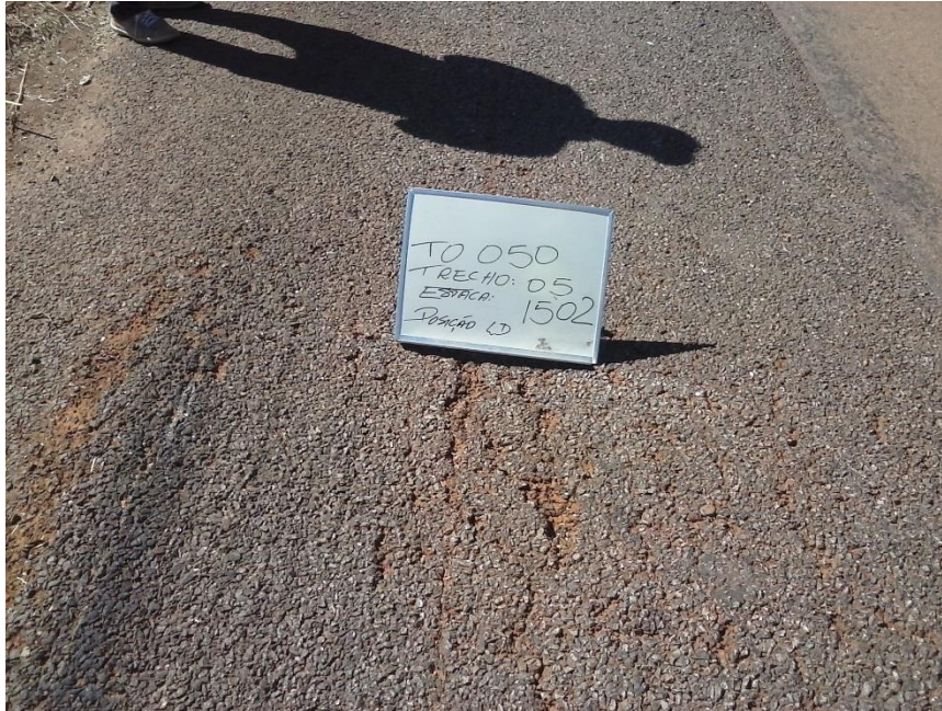
Figura 25 – Remendo comprometido
