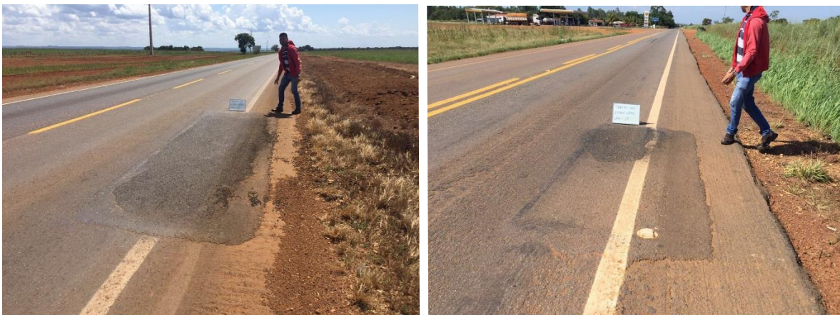
Figura 49 – Reparos realizado no novo revestimento
