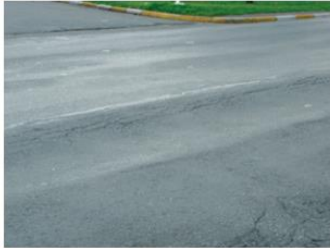
Figura 10 – afundamentos plásticos nas trilhas
