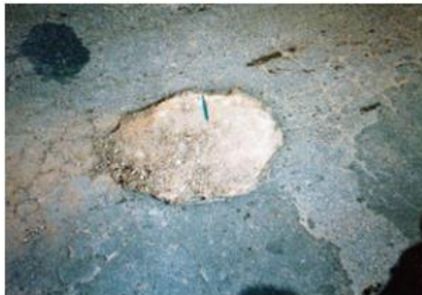
Figura 16 – panela atingindo a base
