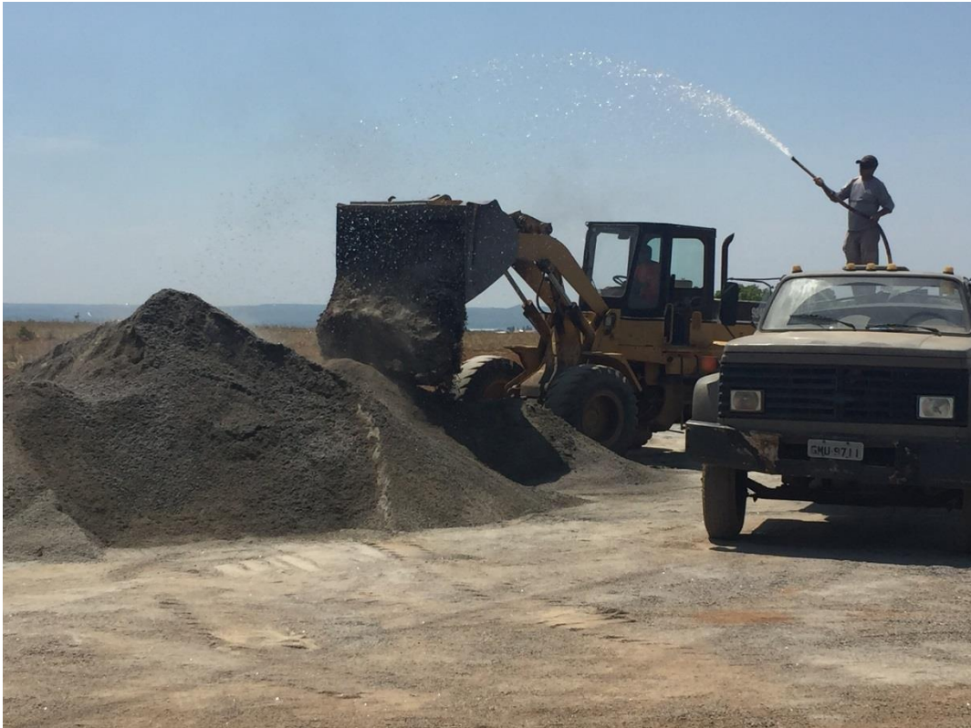
Figura 45 – homogeneização da pilha
