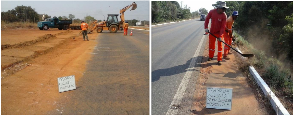
Figura 33 – Limpeza do pavimento
