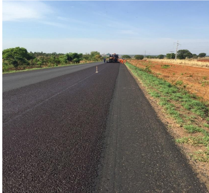
Figura 40 – Alinhamento na execução do MRAF
