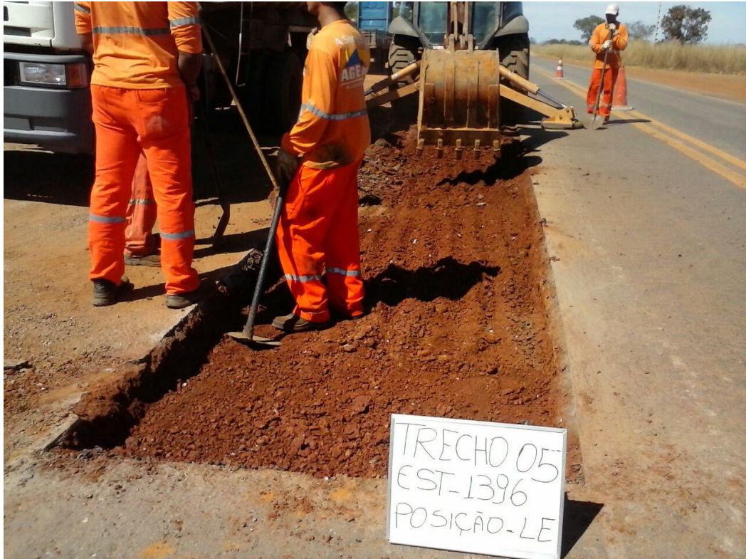
Figura 28 – Remoção do revestimento danificado
