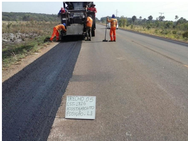
Figura 41 – Aplicação do MRAF no acostamento
