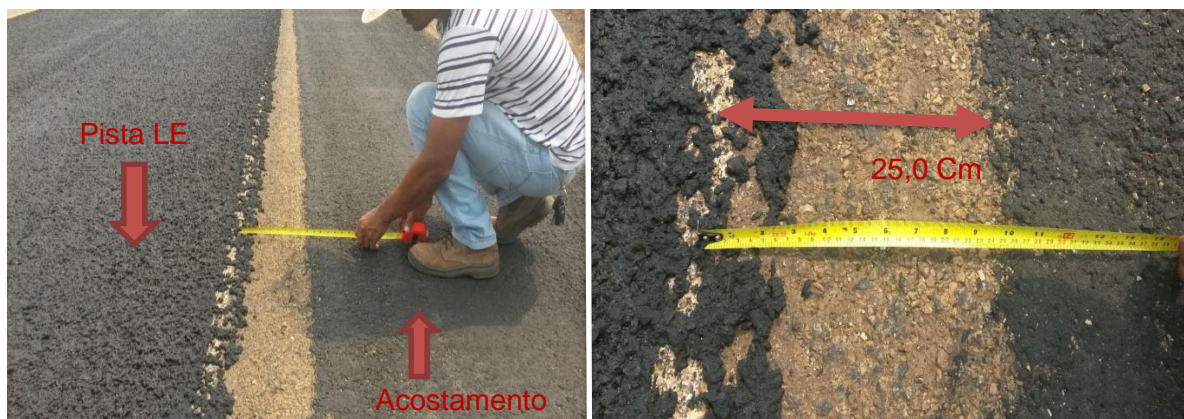
Figura 43 – Falha no fechamento da primeira camada do Micro
