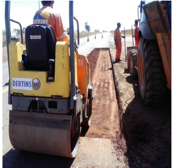
Figura 30 – Compactação da base
