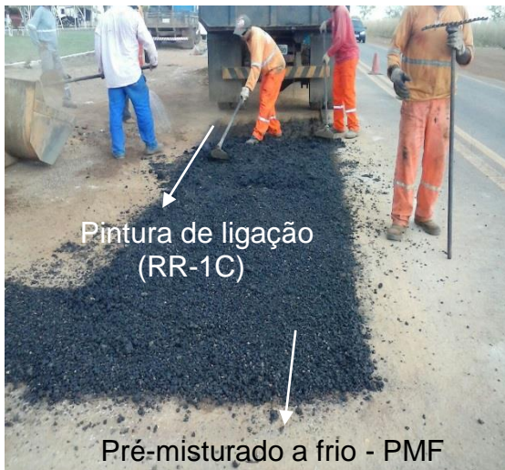
Figura 31 – Pintura de ligação e preenchimento com PMF
