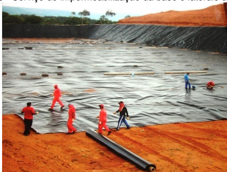
Figura 8 - Serviço de impermeabilização da base e laterais do aterro.
