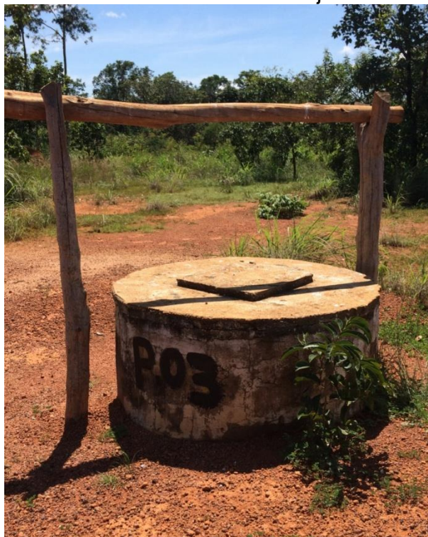
Figura 14 - Poço de monitoramento situado na jusante do Aterro Sanitário.
