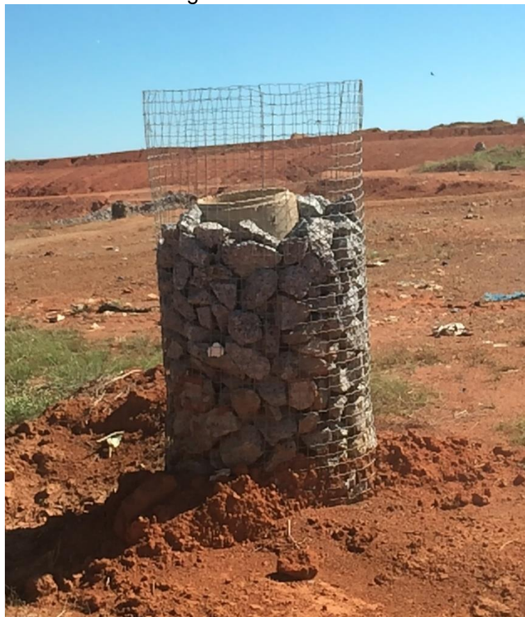
Figura 11 - Drenos de gás a 20 metros de aterro de resíduos.
