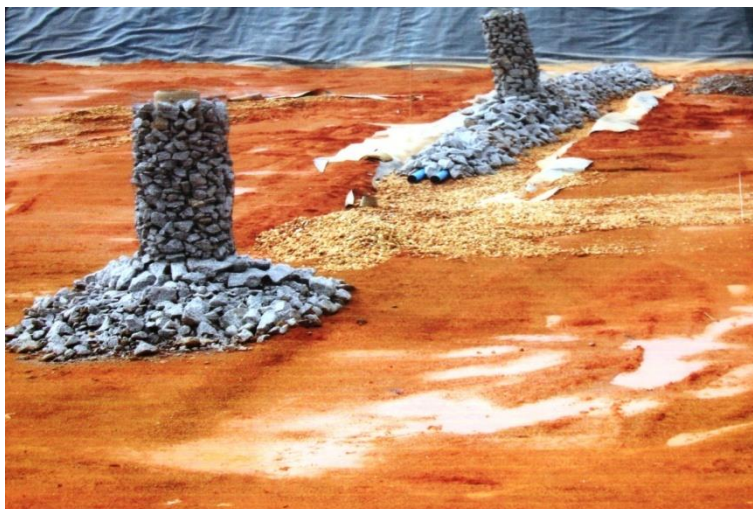
Figura 10 - Drenos de gás na base antes de iniciar o depositam dos resíduos.
