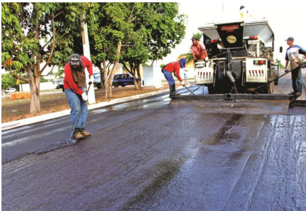
Figura 39: Execução de Recuperação Superficial – Recapeamento usando Lama asfáltica.
