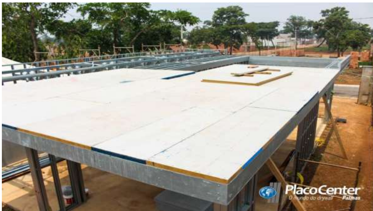
Figura 30: Vedação da laje da casa LSF
