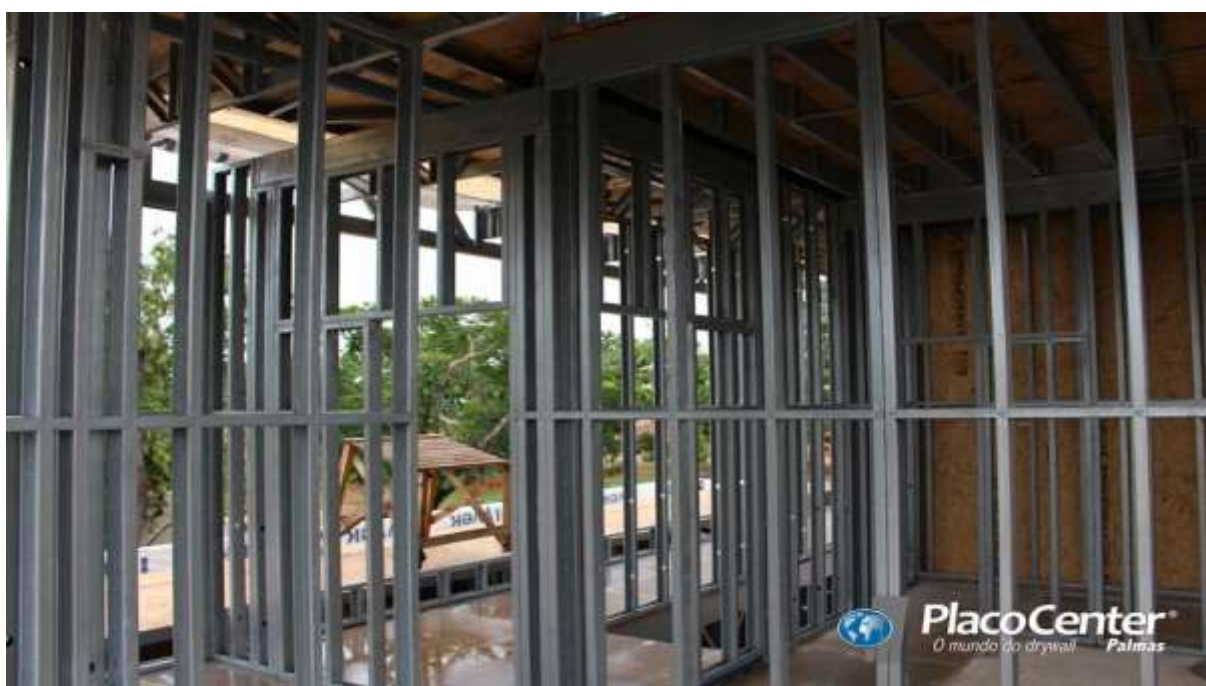
Figura 23: Visão da estrutura interna da habitação em LSF
