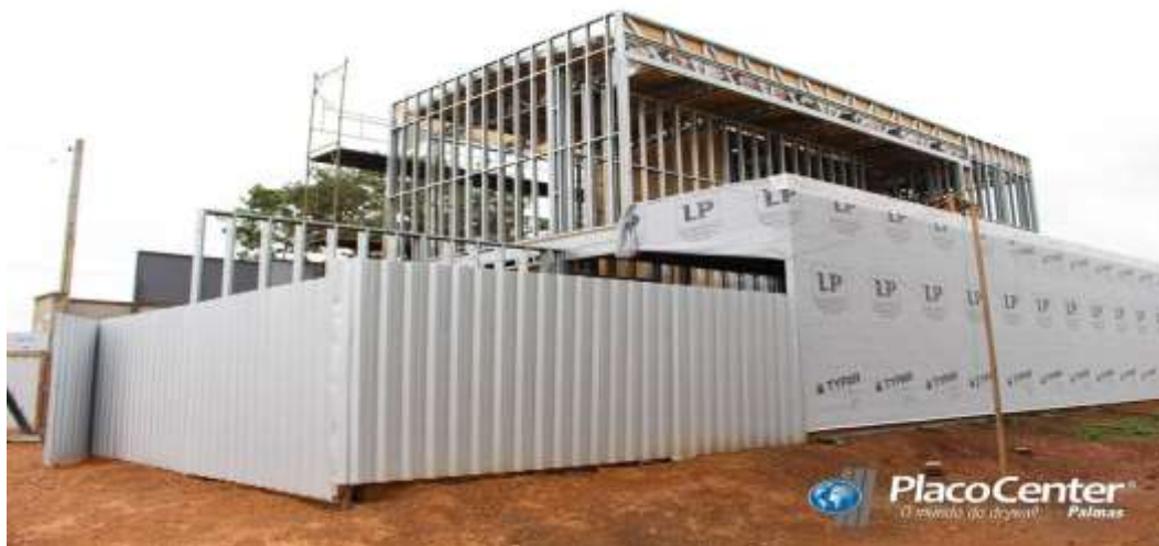
Figura 20: Estrutura da habitação Steel Frame (LSF)
