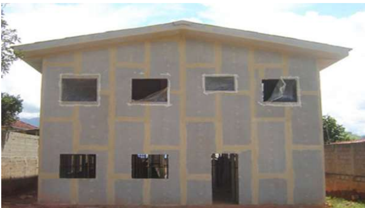
Figura 6: Revestimento externo Sistema LSF
