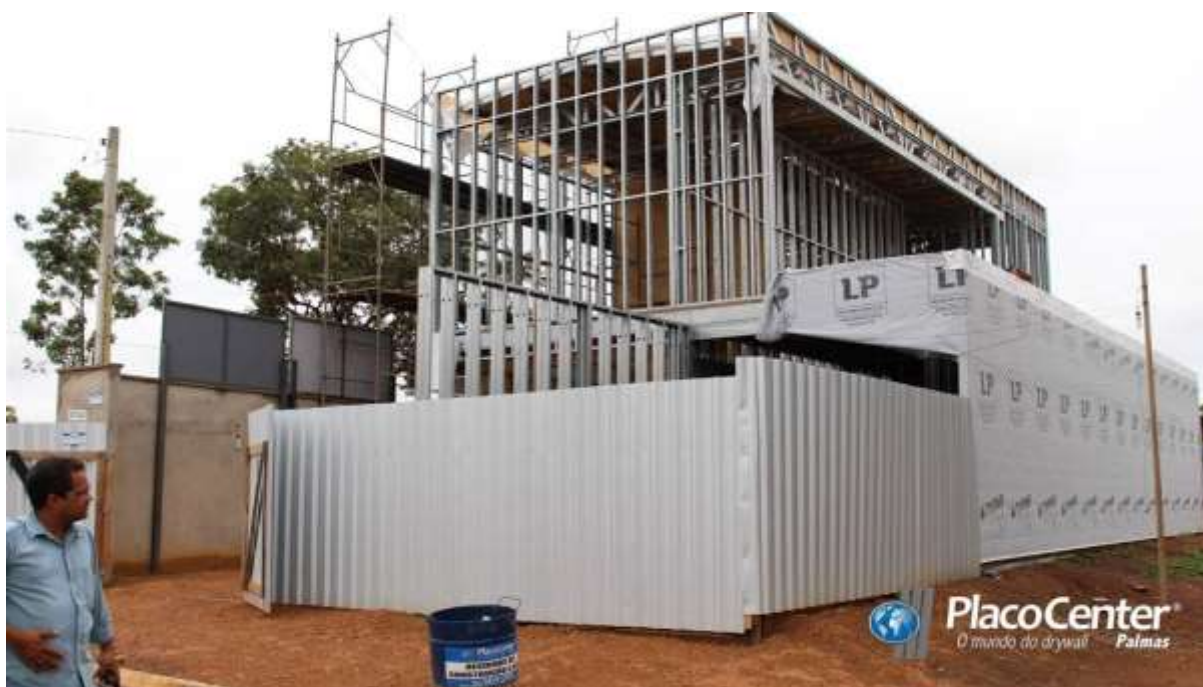
Figura 21: Visão geral da estrutura da casa em LSF
