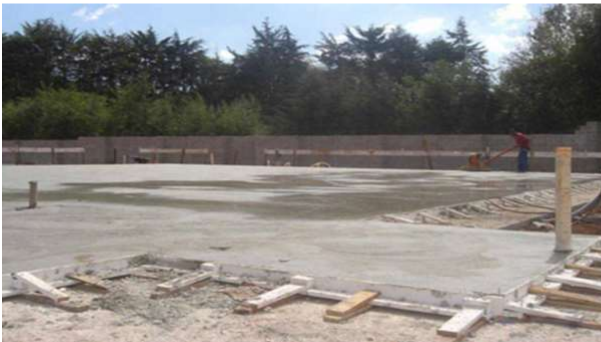
Figura 3: Fundações do Sistema LSF
