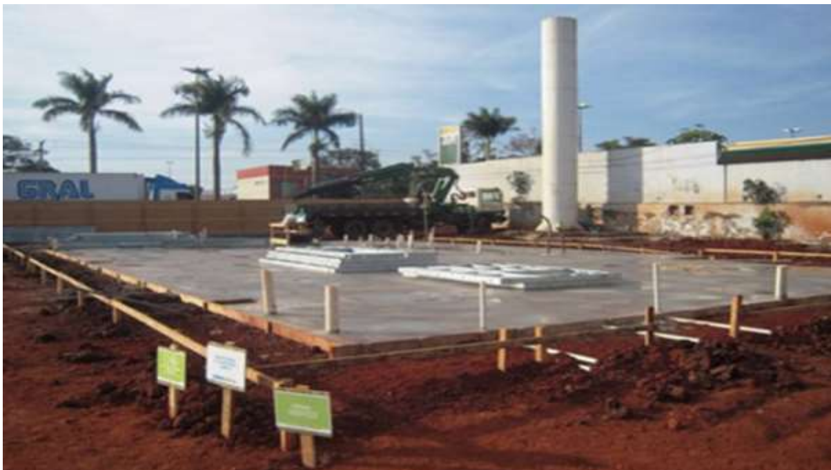
Figura 4: Fundações Sistema Construtivo LSF
