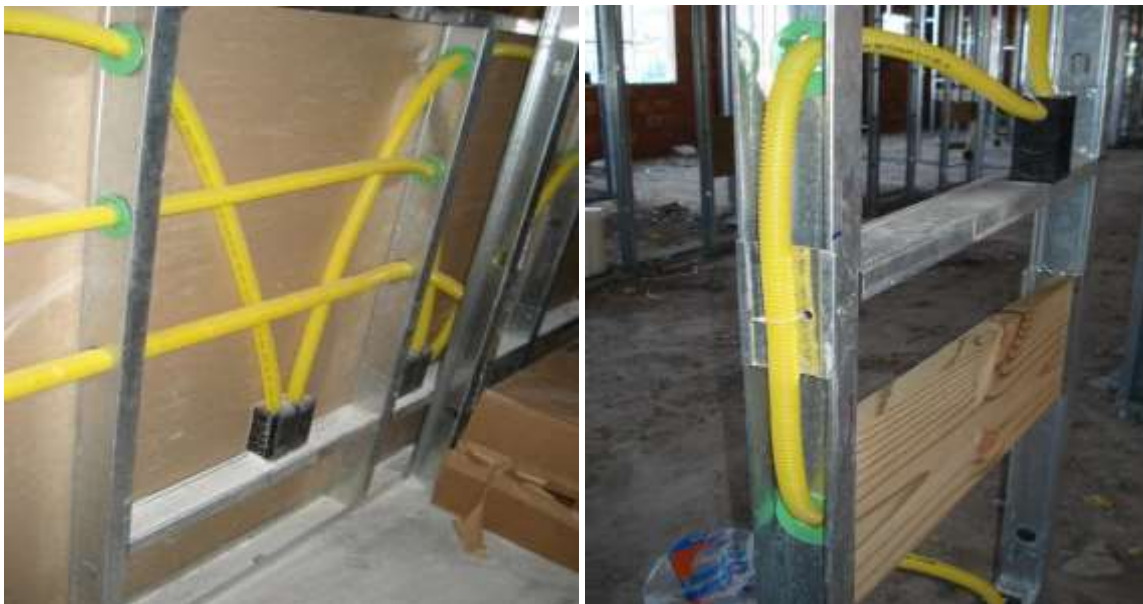
Figura 7: Instalações elétricas no sistema LSF
