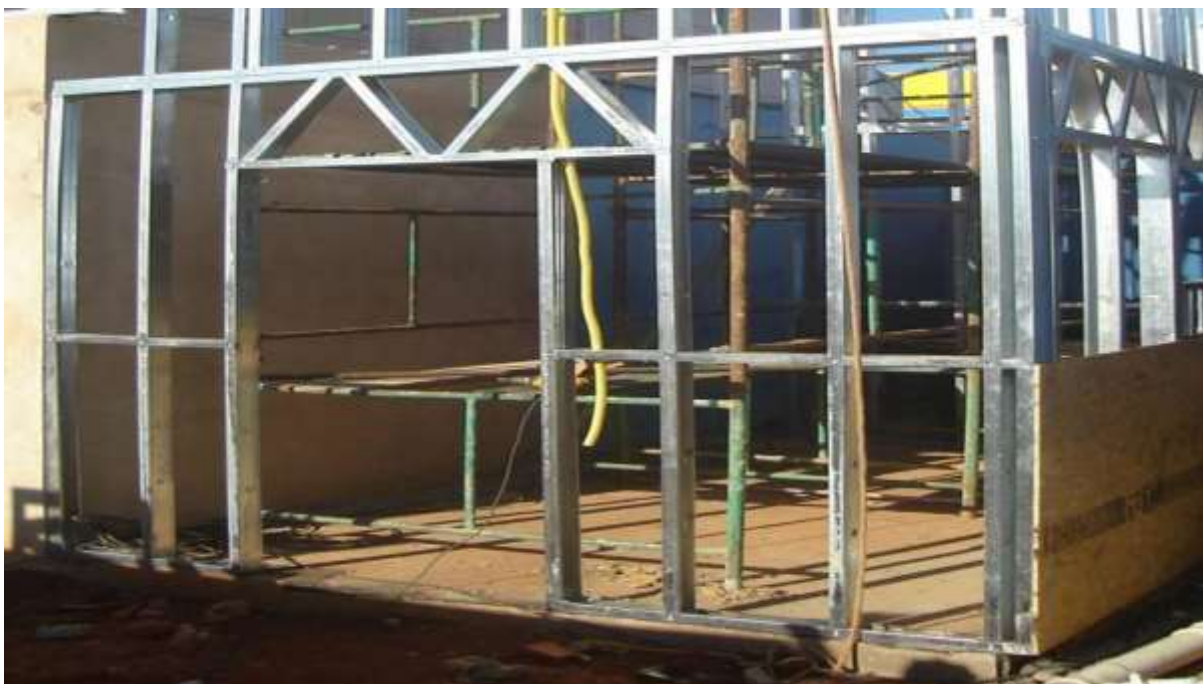
Figura 10: Reforços em portas, perfis combinados
