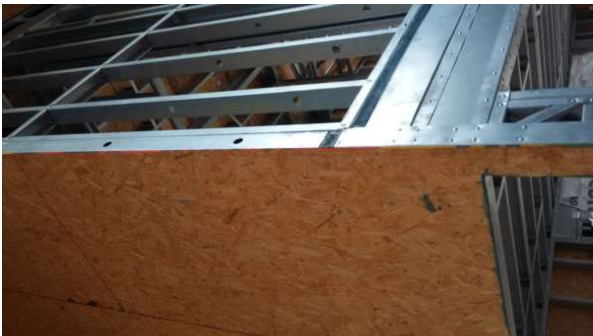
Figura 24: Vedação da estrutura da habitação em LSF
