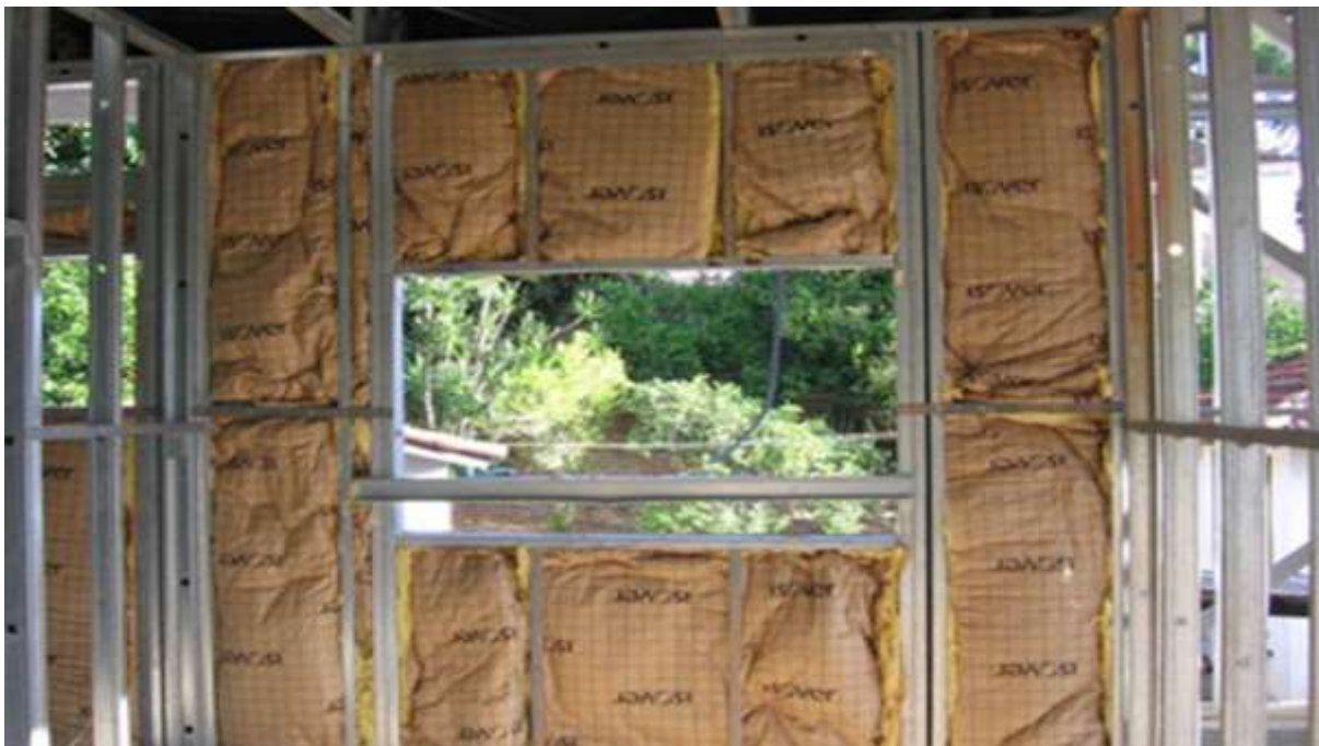
Figura 8: Isolamento térmico e acústico no sistema LSF
