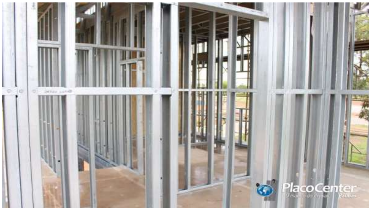
Figura 22: Estrutura interna da habitação em LSF
