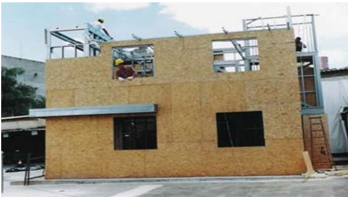
Figura 11: Aplicação de placas OSB em painéis estruturais
