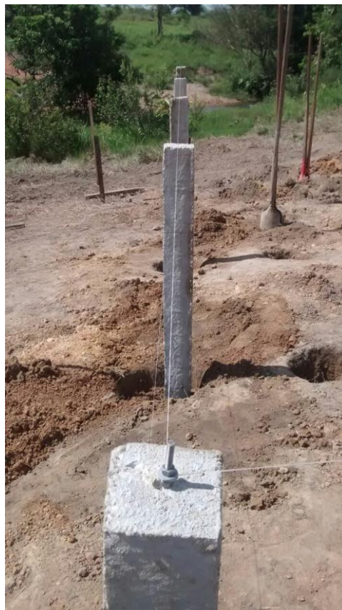
Figura 10. Montagem da estrutura das placas fotovoltaicas
