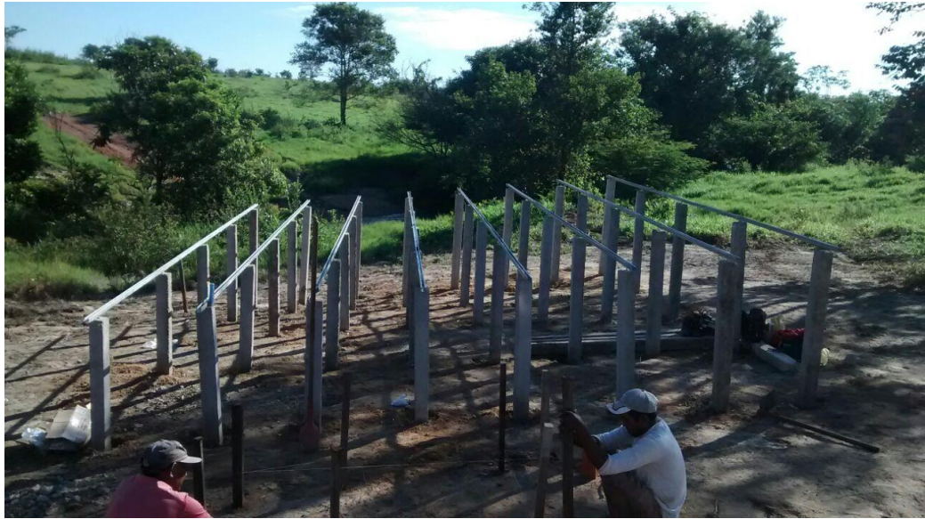
Figura 11. Estrutura das placas fotovoltaicas
