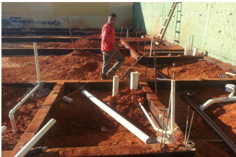
Figura 18. Passagem de Tubulação Hidro sanitária.
