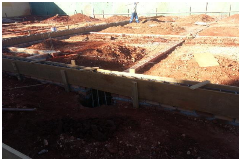
Figura 15. Execução de forma para concretagem das vigas baldrame.
