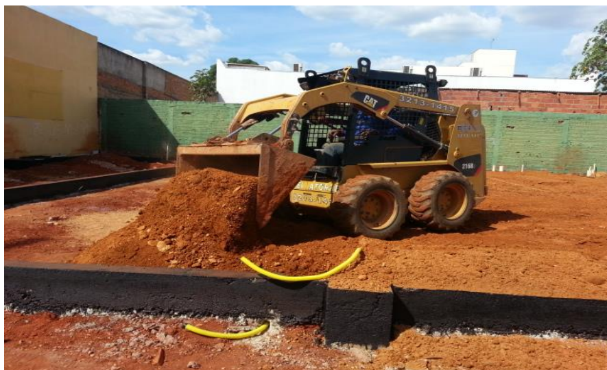
Figura 19. Aterro e reaterro mecanizado.
