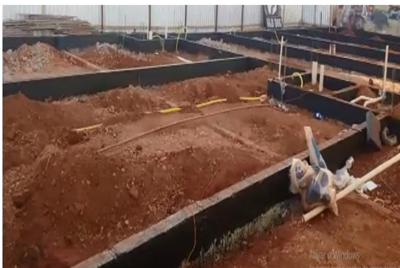
Figura 17. Vigas Baldrames Impermeabilizadas.
