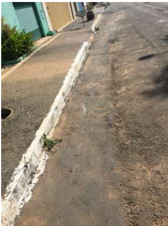
Figura 9: Sarjeta com recapeamento asfáltico.
