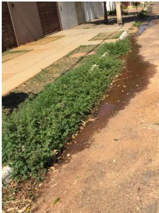
Figura 1: Esgotamento de piscina sendo lançado na sarjeta.
