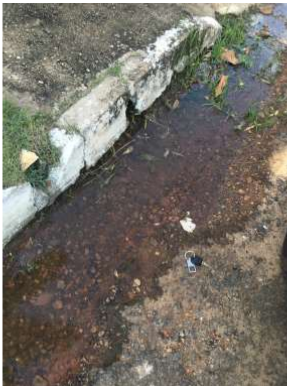
Figura 8: Esgotamento de piscina empossado no sarjeta.
