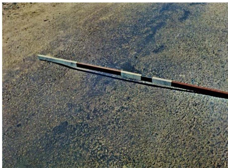
Figura 7 - Representação do afundamento plástico.
