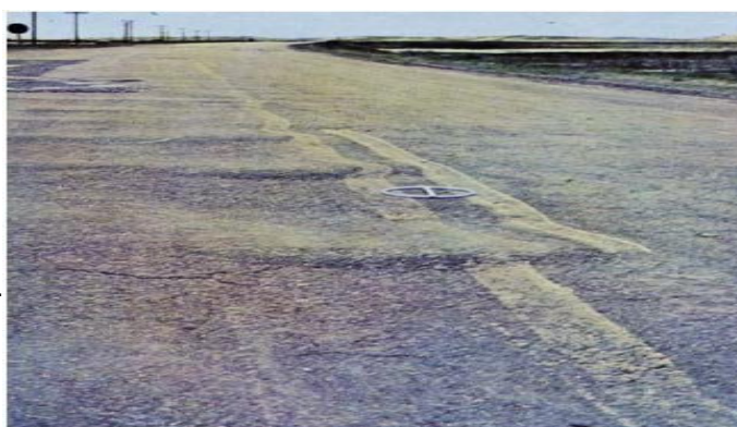
Figura 9 - Representação das ondulações ou corrugações.
