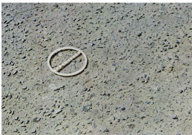
Figura 12 - Representação do desgaste.
