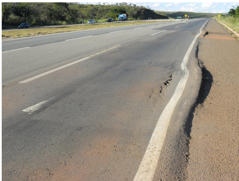
Figura 10 - Representação dos escorregamentos no bordo da pista.
