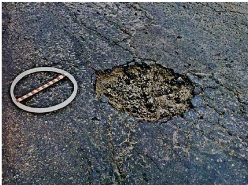
Figura 13 - Representação das painelas ou buracos.
