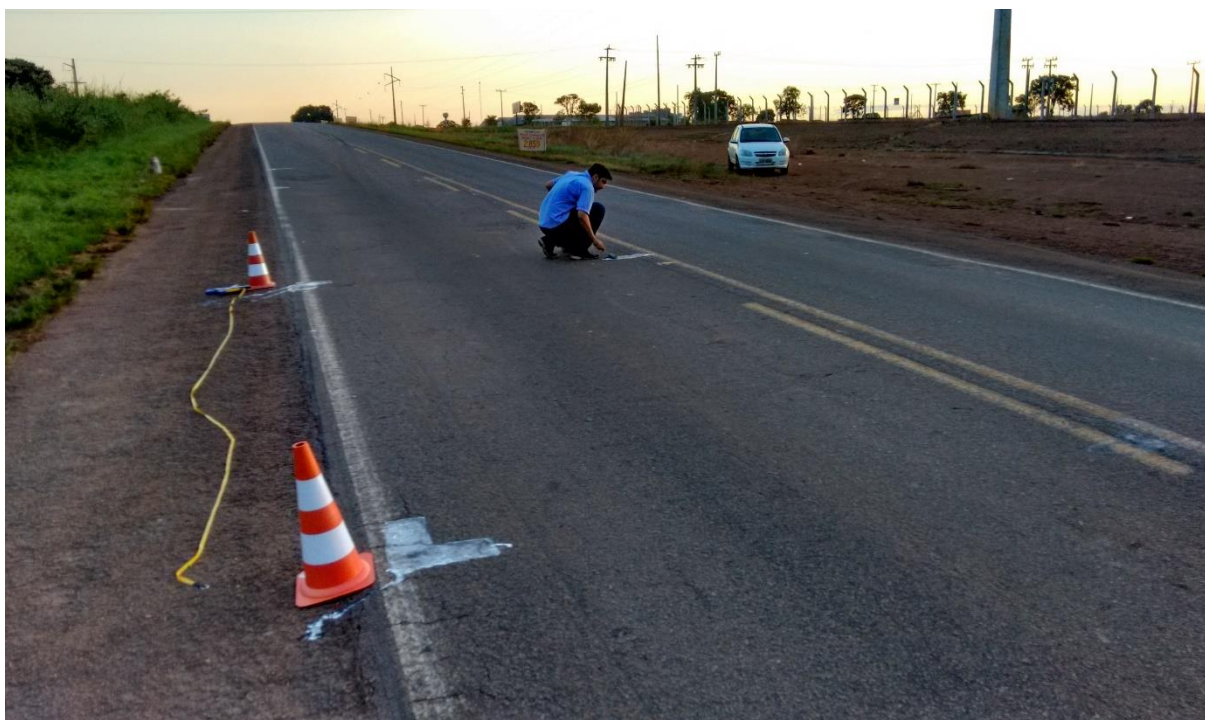
Figura 17 – Demarcação de estação para levantamentos
