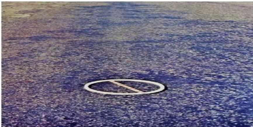
Figura 11 - Representação da exsudação.
