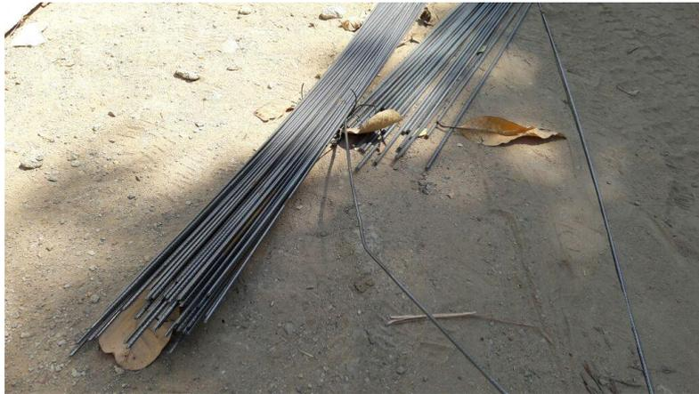
Figura 25: armazenamento inadequado – Fonte: Própria
