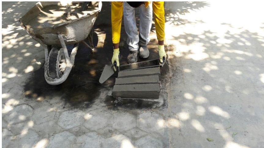
Figura 18: Fôrmas com desmoldante – Fonte: Própria
