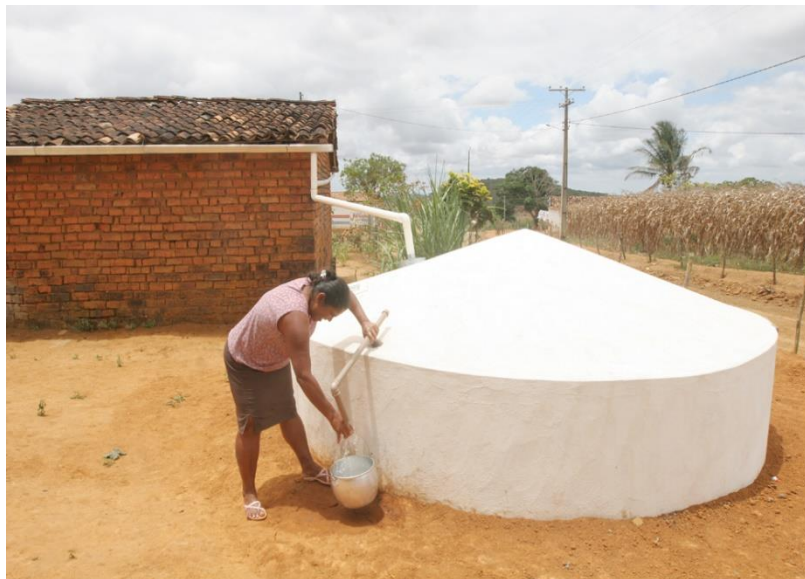
Figura 2.1 – Cisterna utilizada na região Nordeste do Brasil para armazenar água de chuva.
