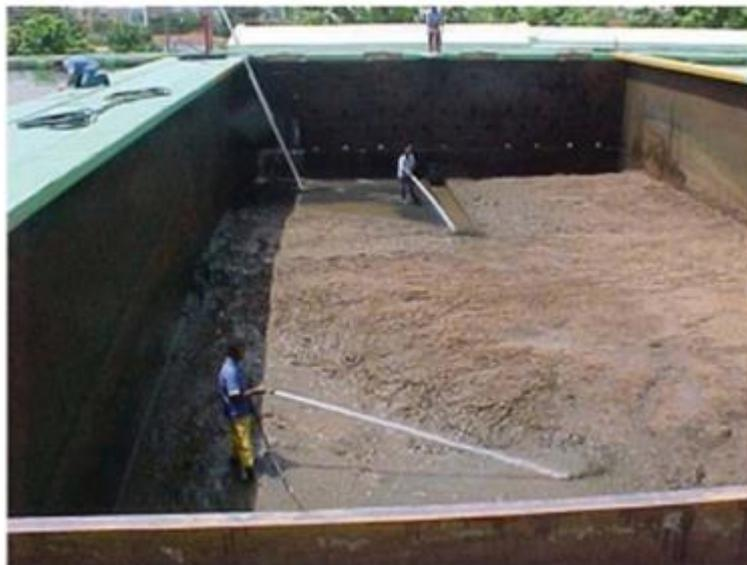
**Figura 4** -Limpeza manualmente de um decantador vazio
