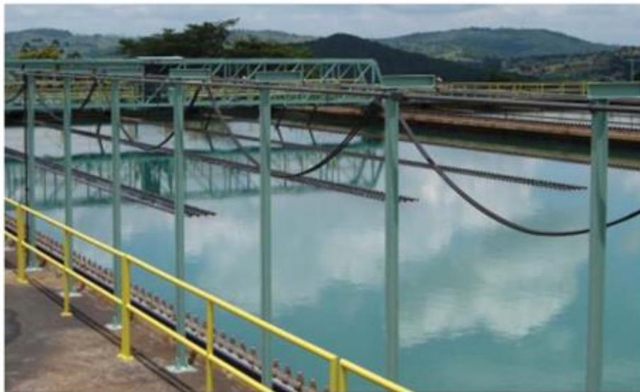
**Figura 2-** Decantador Clássico
