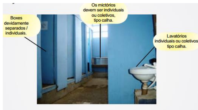
Figura 5 - Caracterização das Instalações Sanitárias
