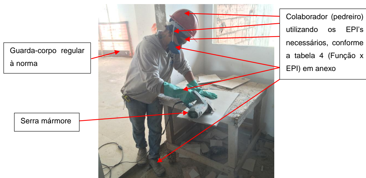
Figura 33 – Assentamento de revestimento de piso (porcelanato)
