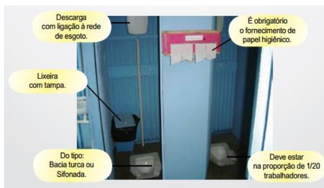
Figura 6 - Caracterização das Instalações Sanitárias
