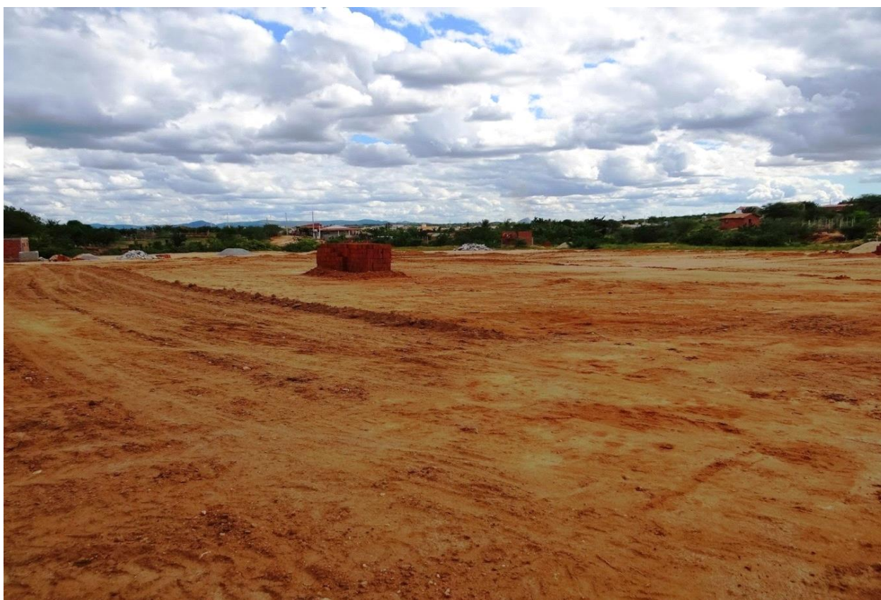
Figura 04 – Execução do campo de futebol.
