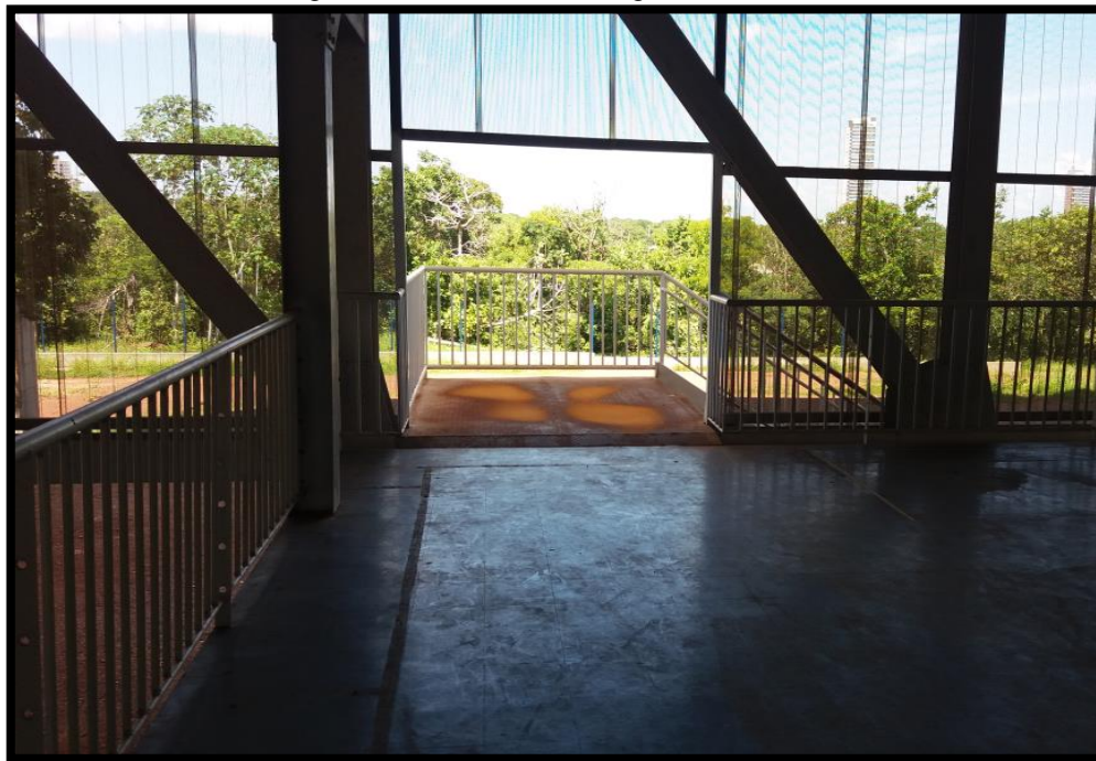
Figura 39 – Saída de emergência mezanino
