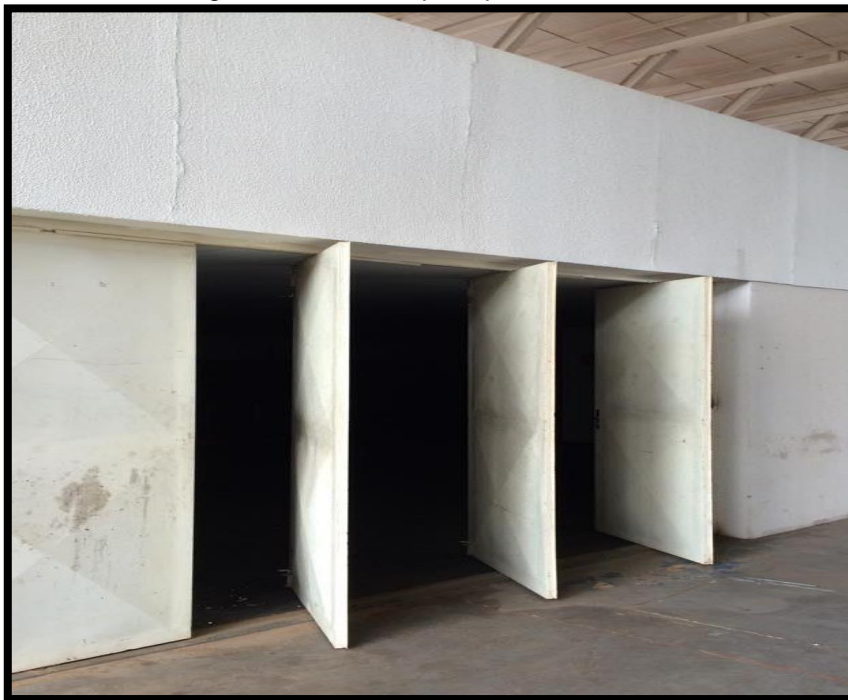
Figura 20 - Entrada principal do Auditório A
