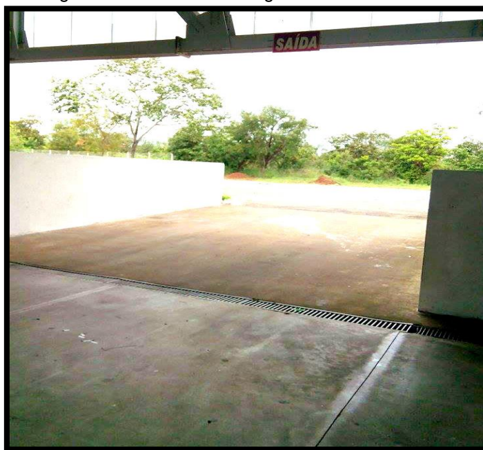
Figura 31 – Saída de Emergência do Salão Térreo.
