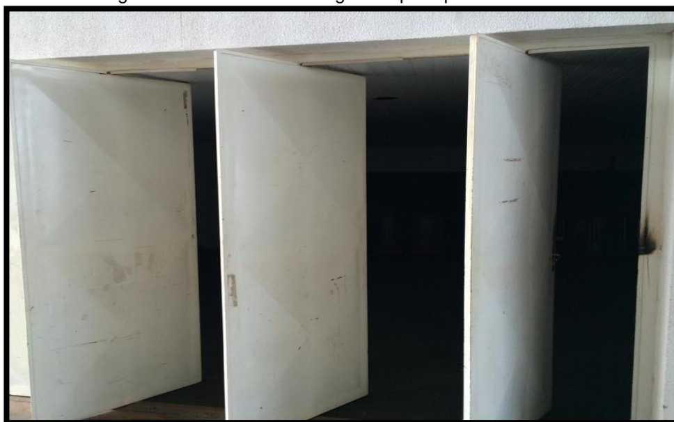
Figura 26 – Saídas de Emergência principal do Auditório B.
