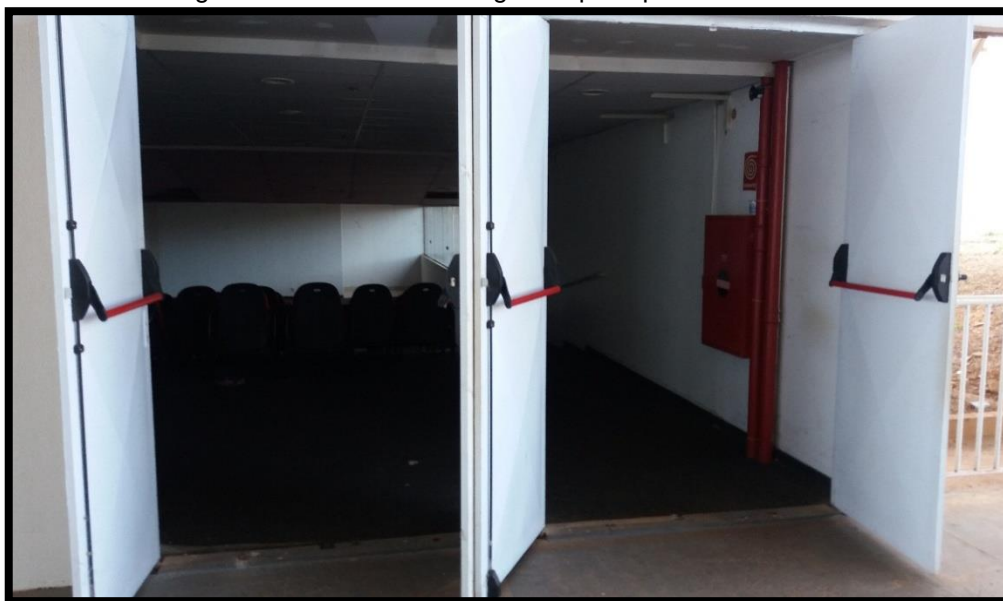
Figura 29 – Saída de Emergência principal do Auditório B.
