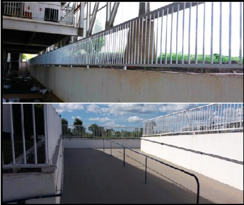
Figura 35– Guarda-corpos nos Muros de Contenção do Salão e Rampas de acesso
