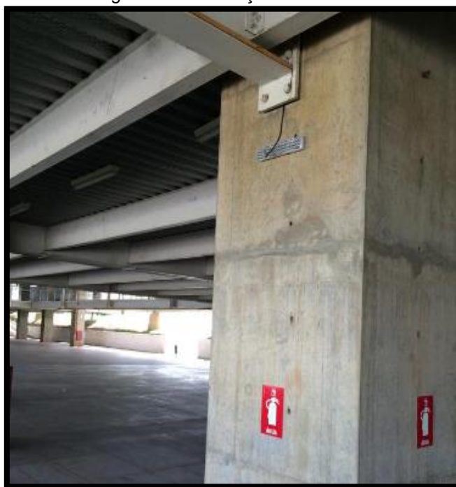
Figura 15 - Instalação de luminária
