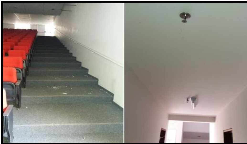
24- Instalações de Sistemas de SPRINKLER e Corrimão nos Corredores Lateral
