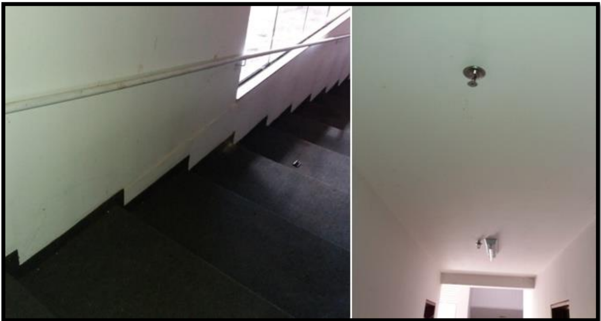
Figura 30 – Instalação de Corrimãos nas Escadas e Sistema de SPRINKLER
