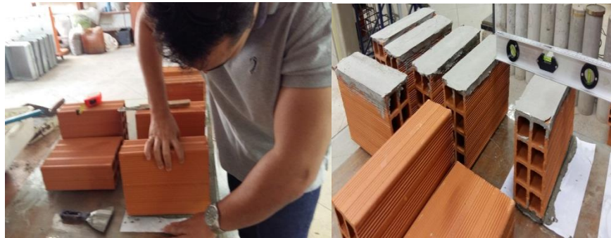
Figura -36 Capeamento dos blocos
