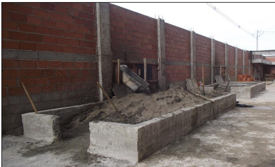
Figura 15 – Ponto de recebimento da argamassa industrializada
