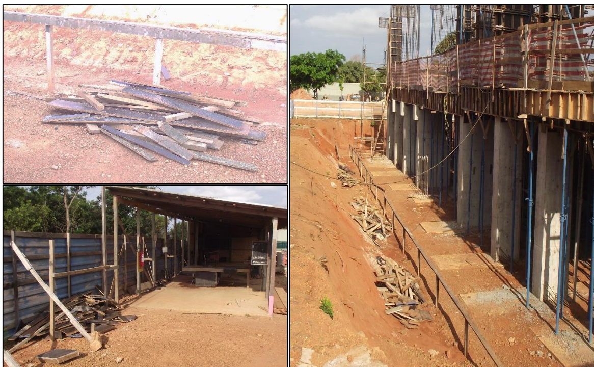
Figura 8 – Montantes de madeira próximos aos pontos de geração no canteiro
