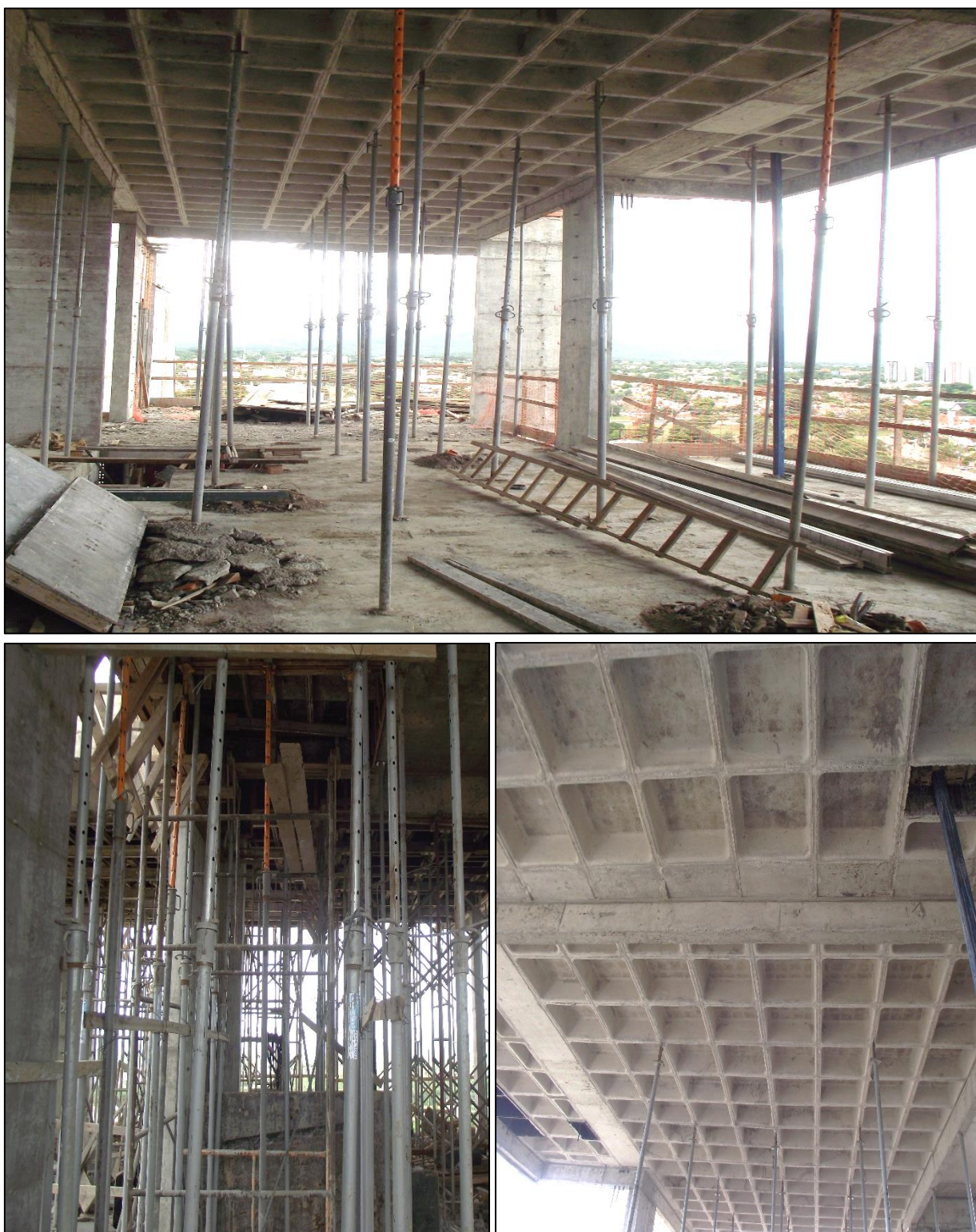
Figura 14 – Escoramento metálico e laje nervurada
