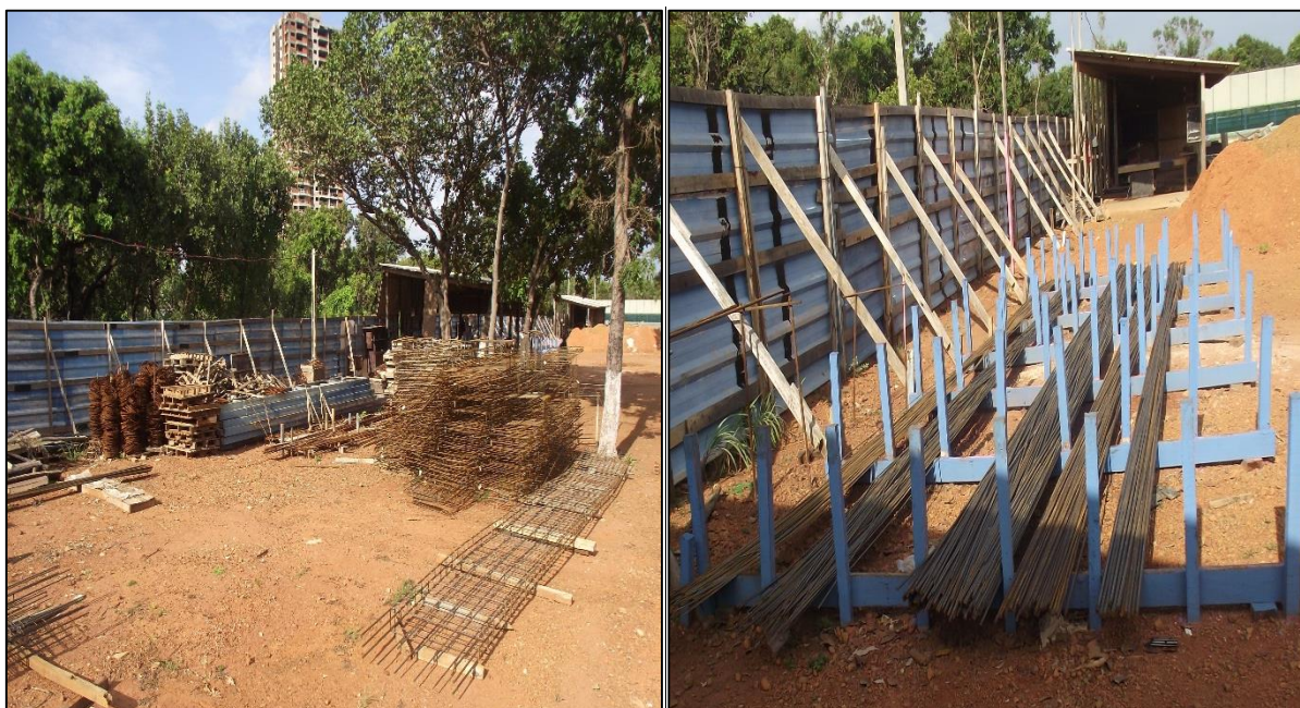
Figura 7 – Armazenamento do aço: vergalhões e corte e dobra
