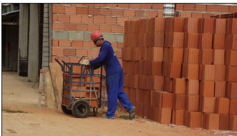
Figura 13 – Uso de carrinhos para o transporte do bloco cerâmico para vedação
