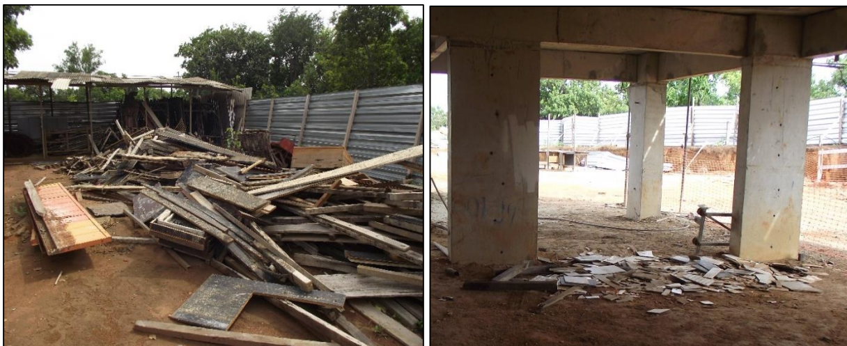
Figura 11 – Acondicionamento de madeiras e restos de cerâmica para “taliscamento” do piso
