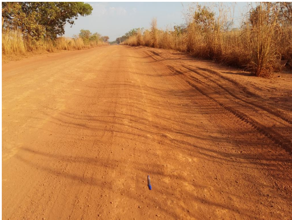
Figura 43: Trecho com trilha de roda
