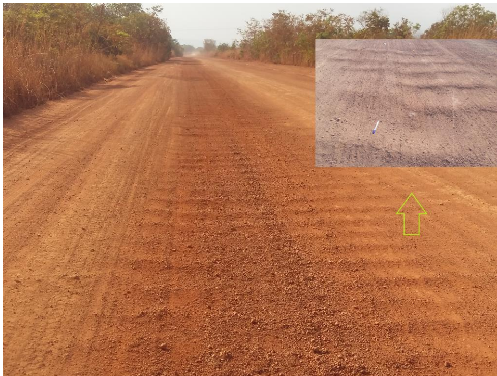
Figura 40: Trecho com corrugações
