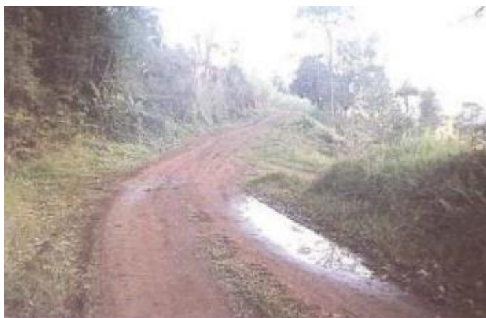
Figura 7: Drenagem lateral inadequada
