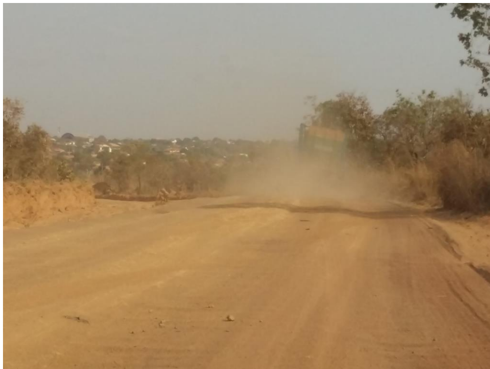
Figura 41: Trecho com excesso de poeira
