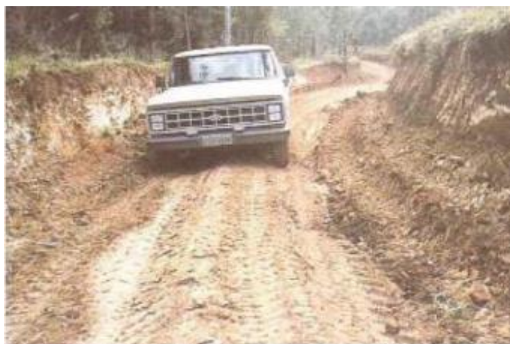
Figura 6: Seção transversal imprópria
