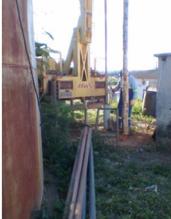
Figura 18 - Reinstalação da bomba submersa.
