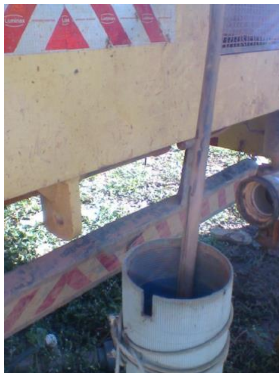
Figura 22 - Procedimento de retirada da bomba submersa.
