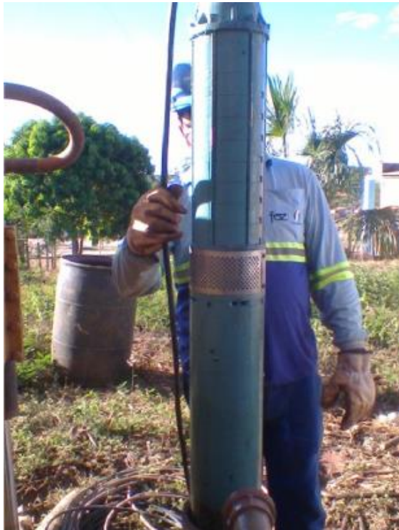
Figura 16 - Bomba submersa retirada.
