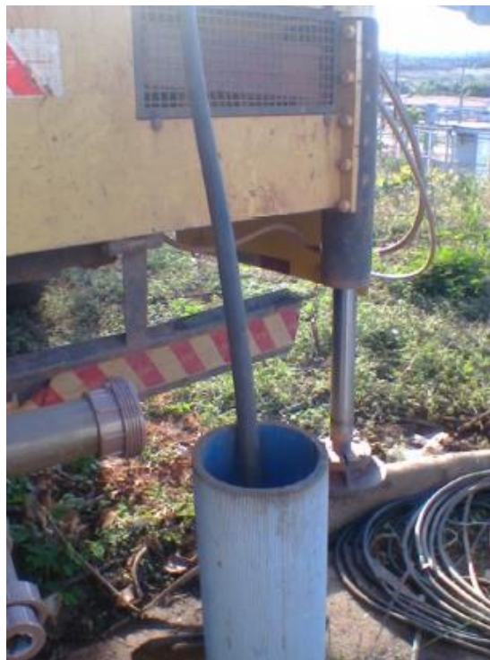
Figura 17 - Realização do procedimento de limpeza através da utilização do compressor de ar (método Air Lift).
