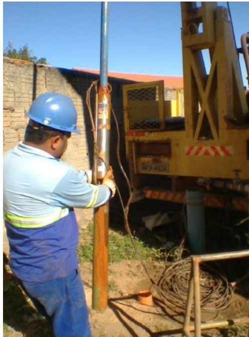
Figura 22 - Procedimento de retirada da bomba submersa.
