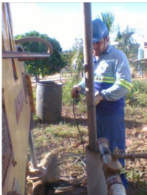
Figura 15 - Procedimento de retirada da bomba submersa.
