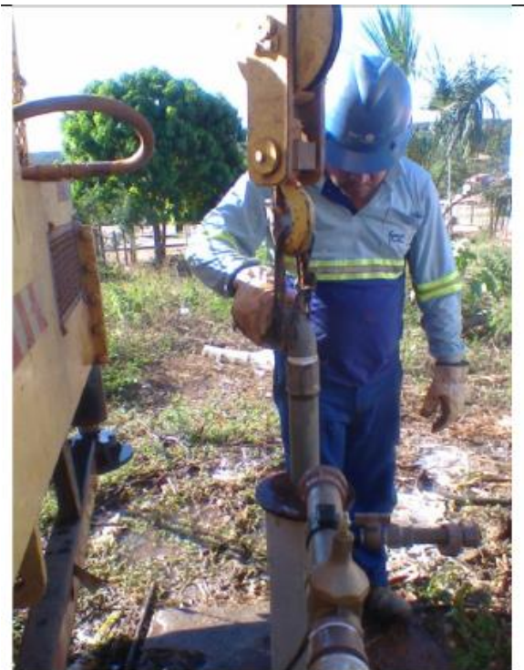
Figura 14 - Início das atividades, desmontagem do barrilete para içamento de tubulação.
