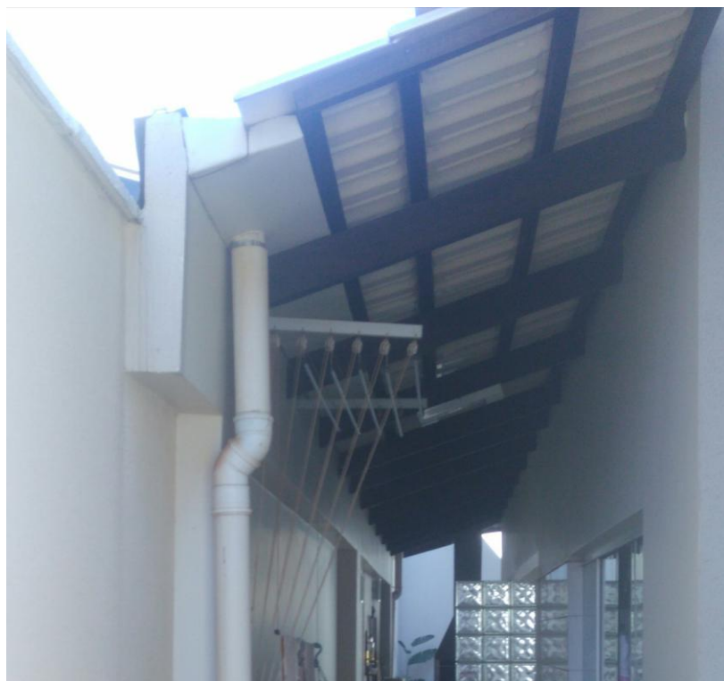
Figura 8 – Vista do sistema de calhas
