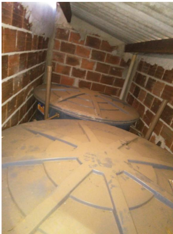
Figura 2 – Reservatórios superiores
