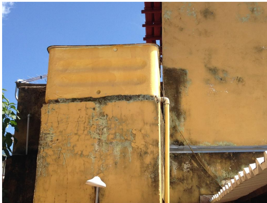
Figura 12 - Reservatório domiciliar de cimento-amianto no Ponto 4.
