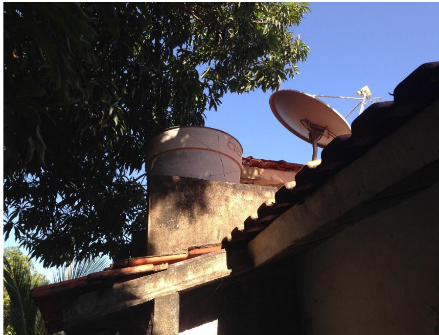
Figura 9 - Reservatório domiciliar de cimento-amianto no Ponto 1.
