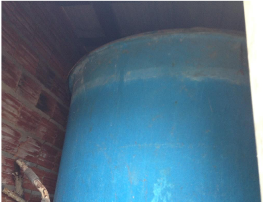
Figura 13 - Reservatório domiciliar de cimento-amianto no Ponto 5.
