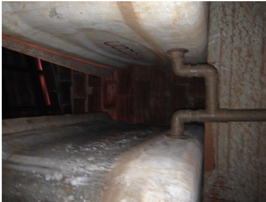
Figura 14 - Reservatório domiciliar de cimento-amianto no Ponto 6
