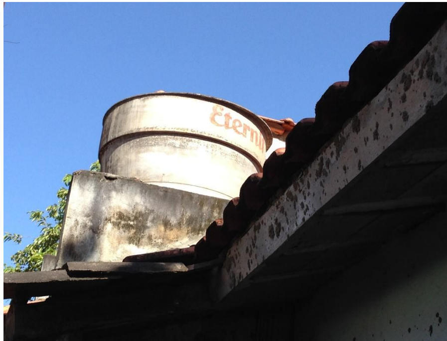
Figura 11 - Reservatório domiciliar de cimento-amianto no Ponto 3.
