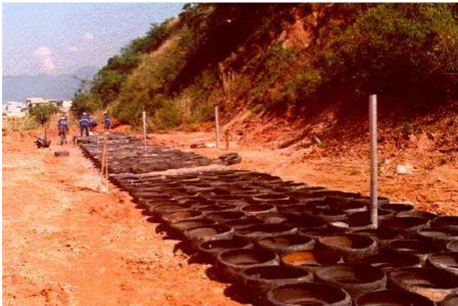
Figura 46- Correção erosiva inicial usando septos de pneu
