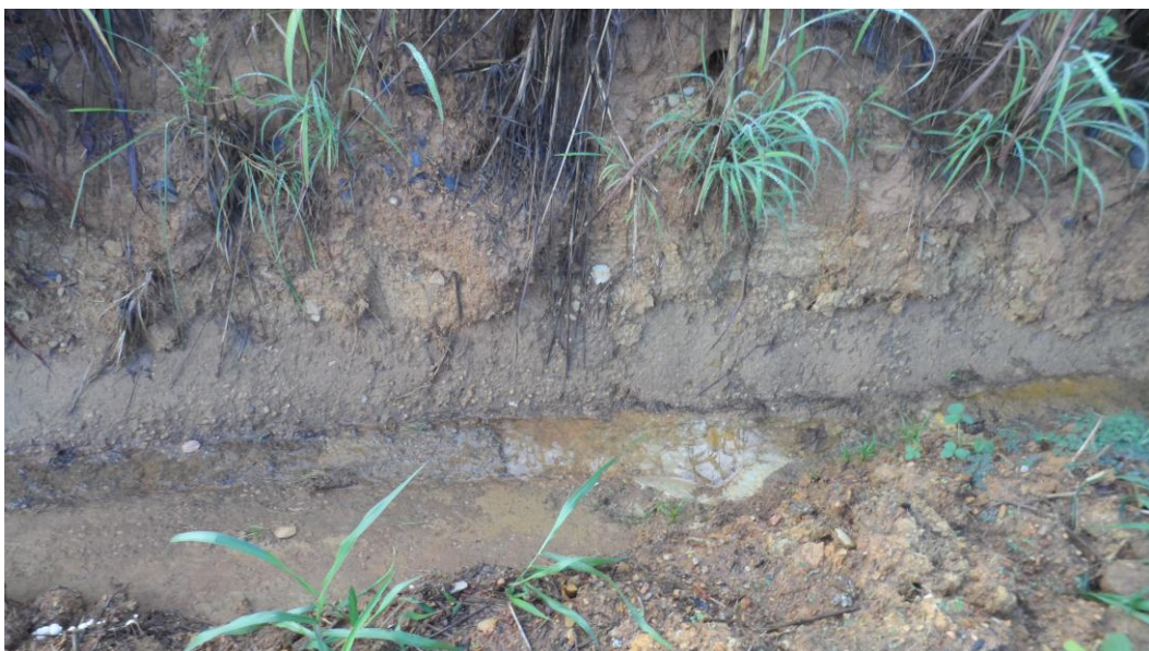
Figura 31 -Valeta de proteção de aterros
