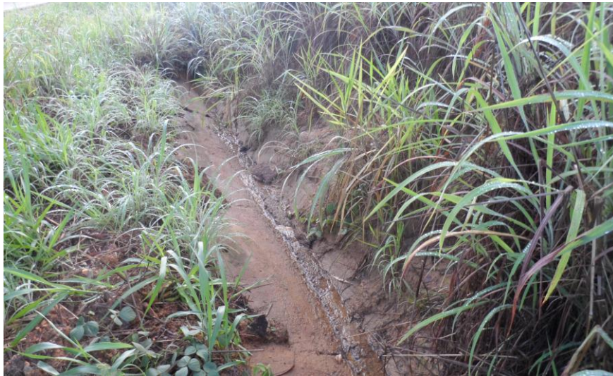
Figura 32- Estado de conservação de valeta
