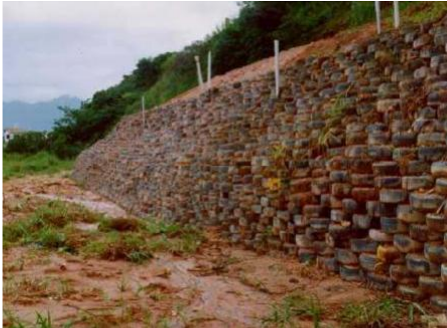
Figura 47- Obra de controle de erosão finalizada
