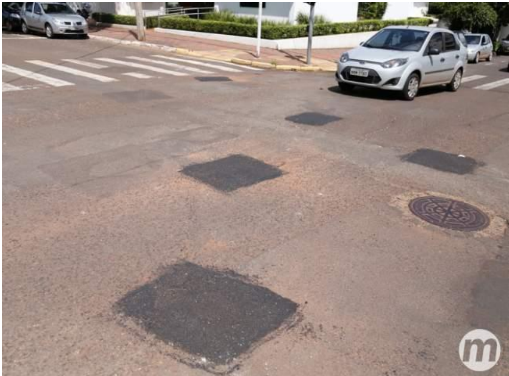
Figura 26- Forma da superfície seguindo os critérios da operação tapa buraco.
