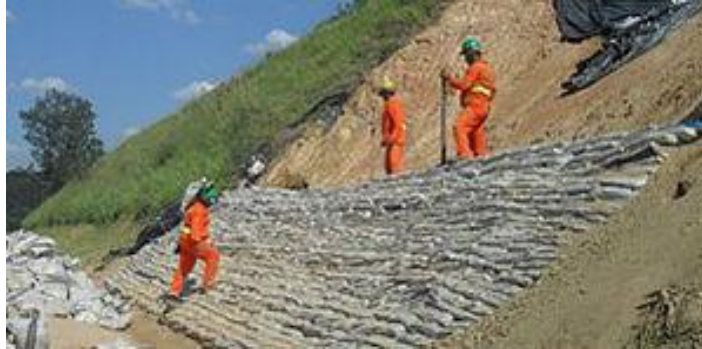
Figura 45- Correções de erosão em talude com solo cimento
