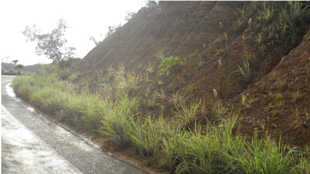
Figura 28- Talude de Corte
