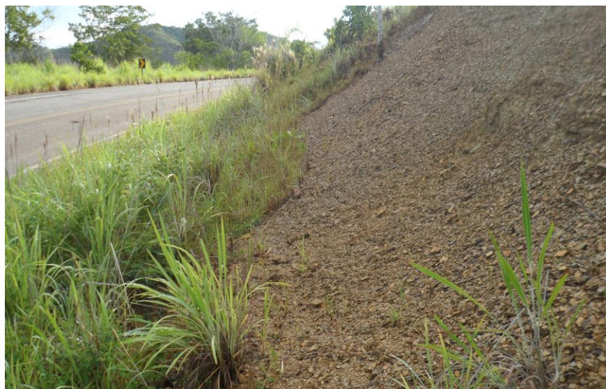
Figura 33- Pé de Talude
