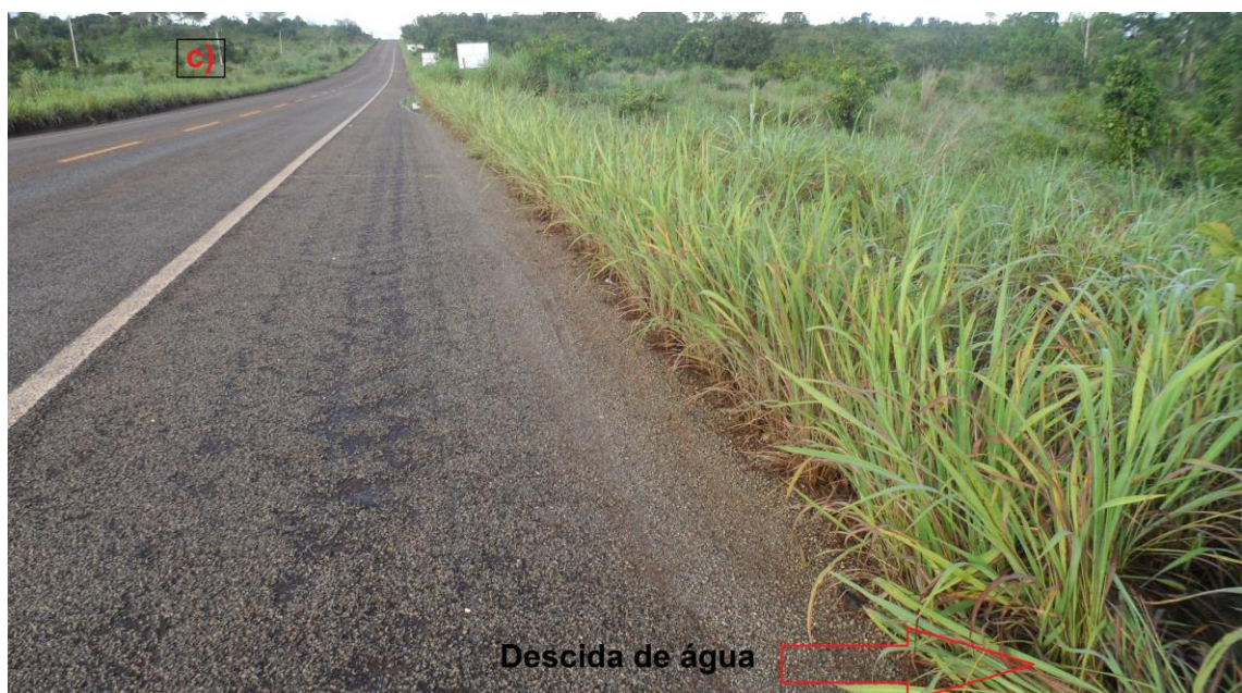
Figura 43- Distância entre poça de água e a descida
