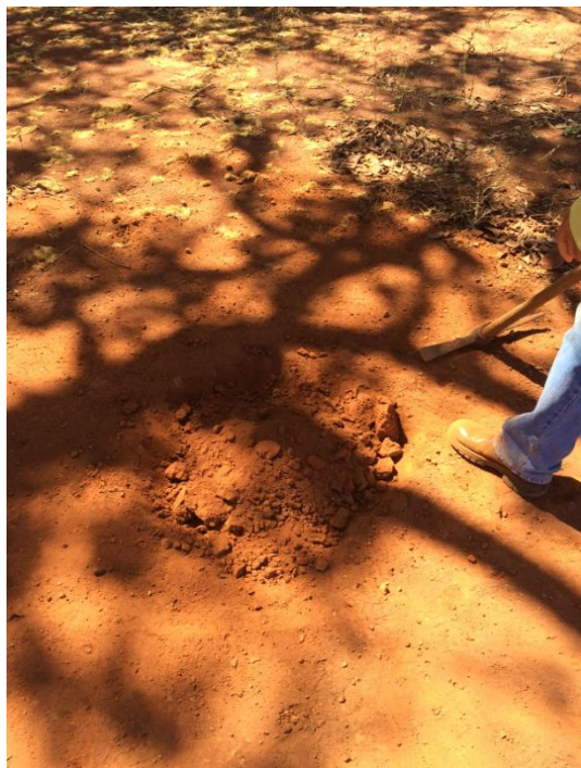
Foto 01 - Coleta do Material de Subleito
