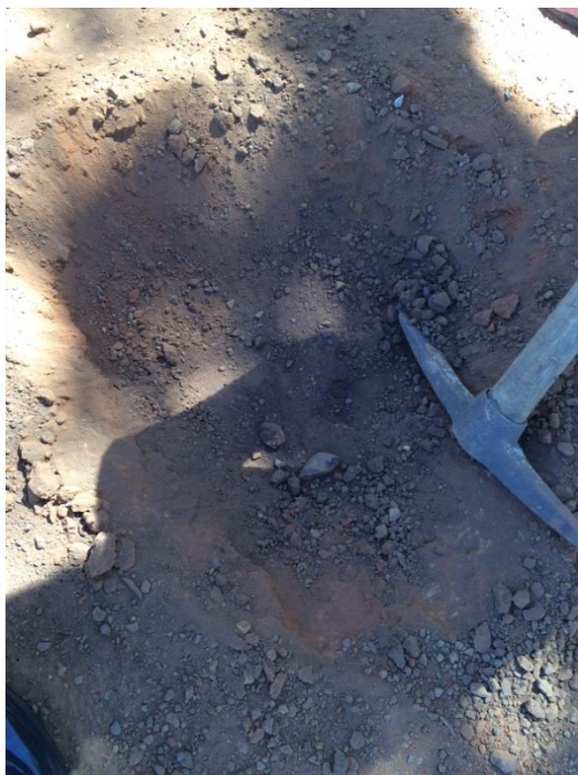
Foto 02 - Coleta do Material de Subleito
