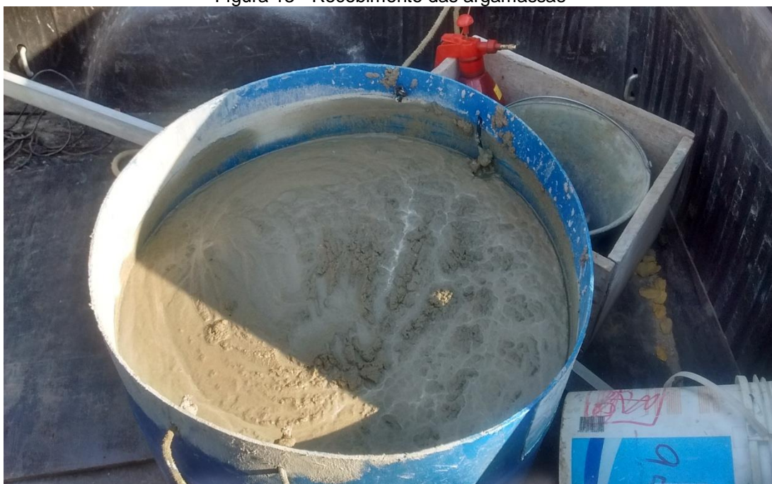
Figura 13 - Recebimento das argamassas
