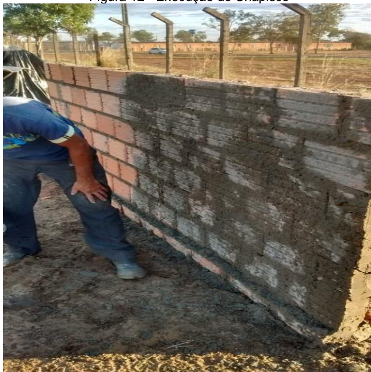
Figura 12 - Execução do Chapisco
