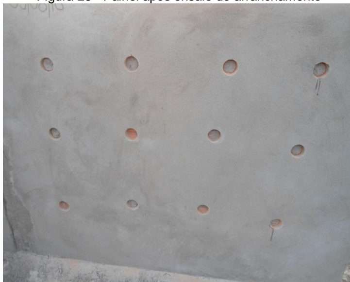
Figura 26 - Painel após ensaio de arranchamento
