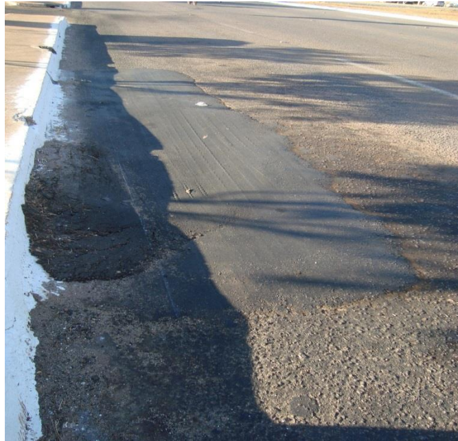
Figura 20: Remendos I- Estação Krahô.
