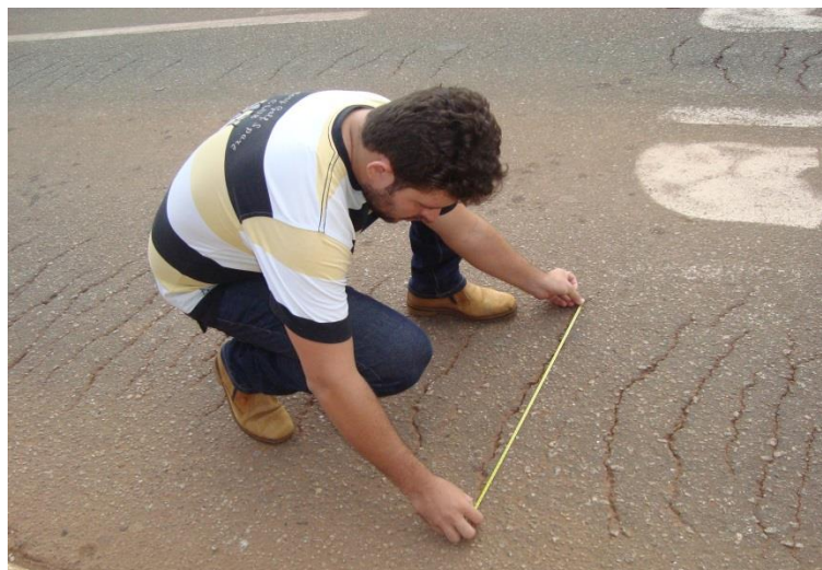
Figura 23: Afundamento da trilha de roda- em frente à Estação Krahô.
