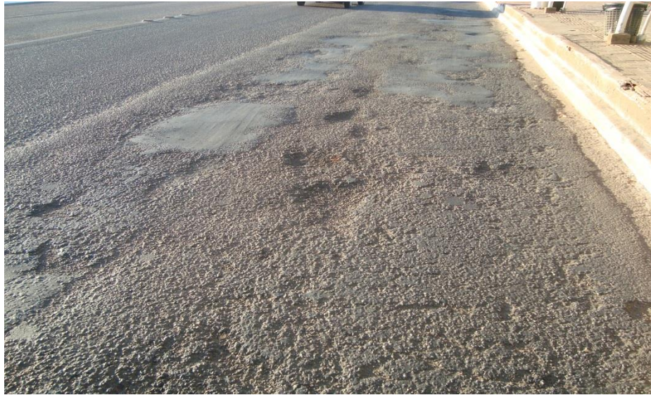
Figura 27: Remendos- Estação Xambioá.
