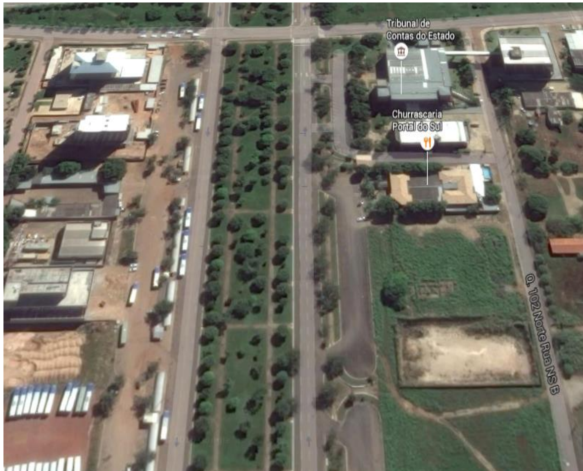
Figura 16: Imagem da Estação Apinajé, na Avenida Teotônio Segurado em Palmas-TO.
