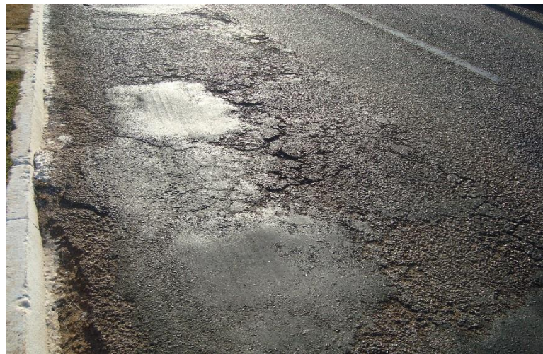
Figura 21: Remendos II- Estação Krahô.
