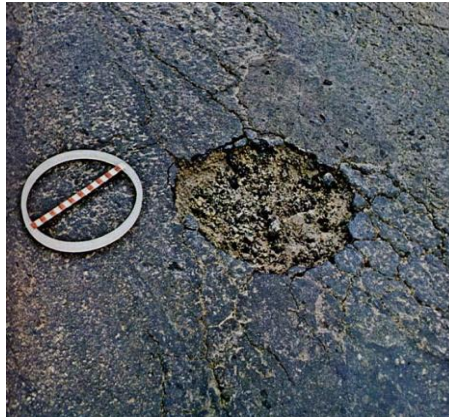
Figura 11: Panela ou buraco.
