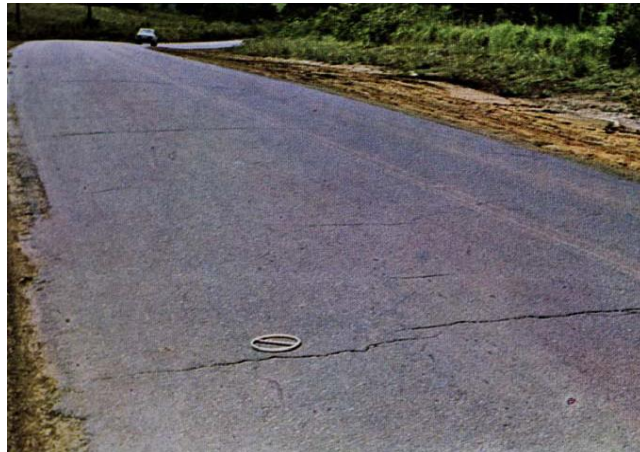
Figura 4: Trinca isolada-transversal.
