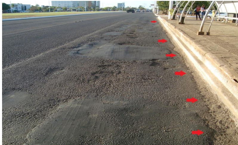
Figura 28: Escorregamento- Estação Xambioá.
