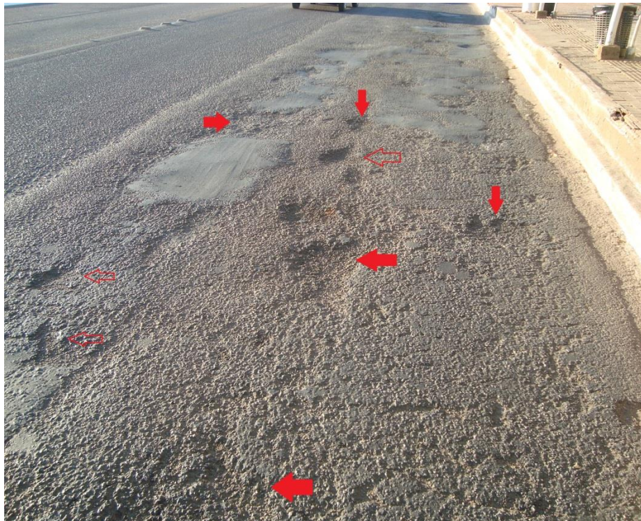
Figura 31: Exsudação- Estação Xambioá.
