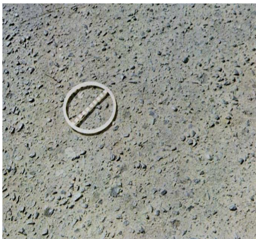
Figura 10: Desgaste (D).
