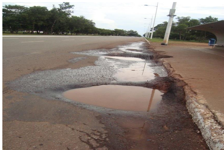
Figura 17: Painelas I- Estação Krahô.
