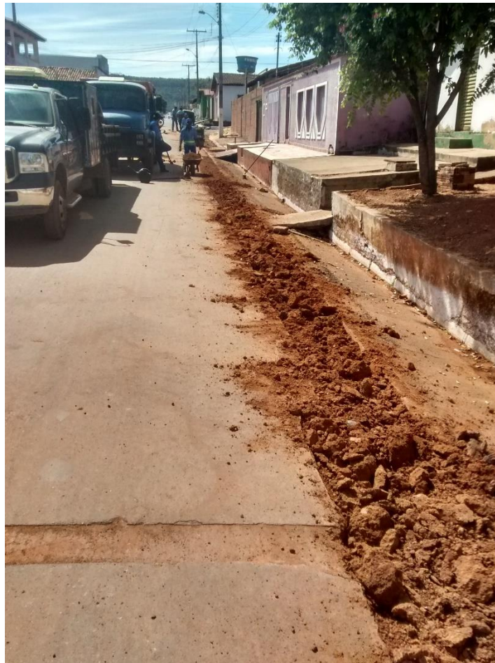
Fig. 3: Retirada de material compactado.
