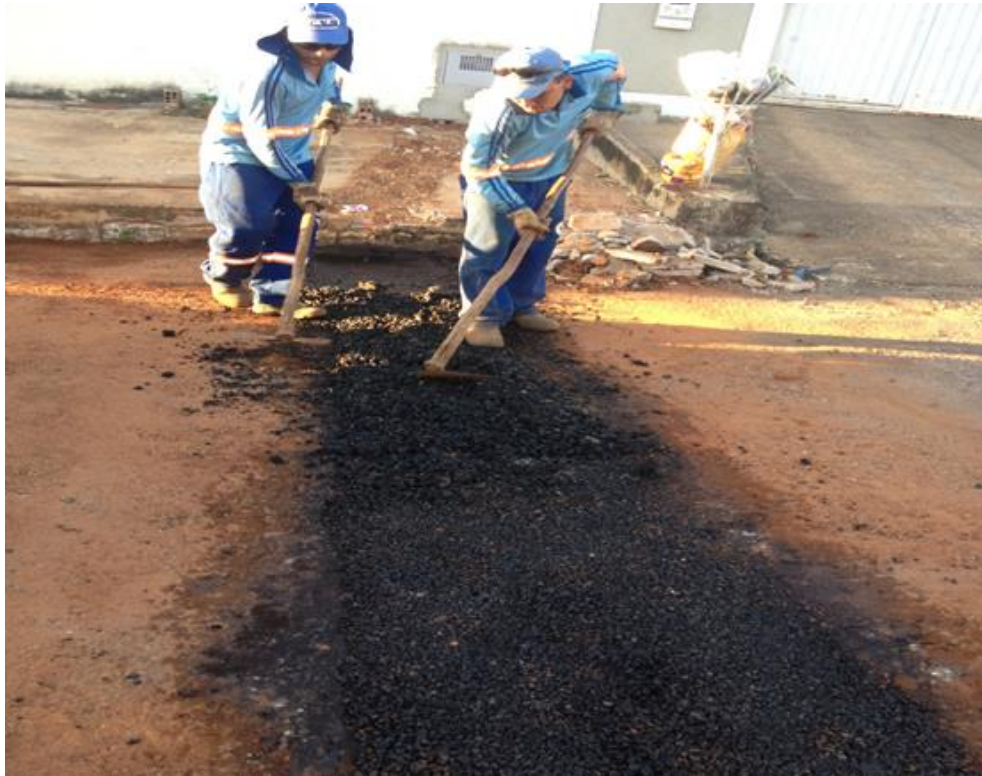
Fig. 6: Espalhamento de emulsão asfáltica.
