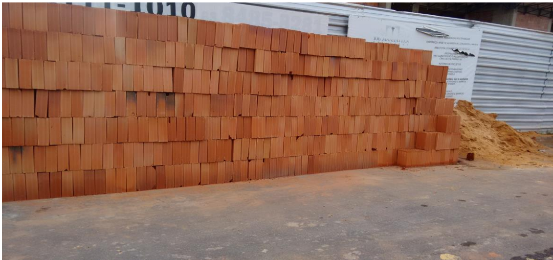
Figura 18: Disposição dos materiais nos arruamentos
