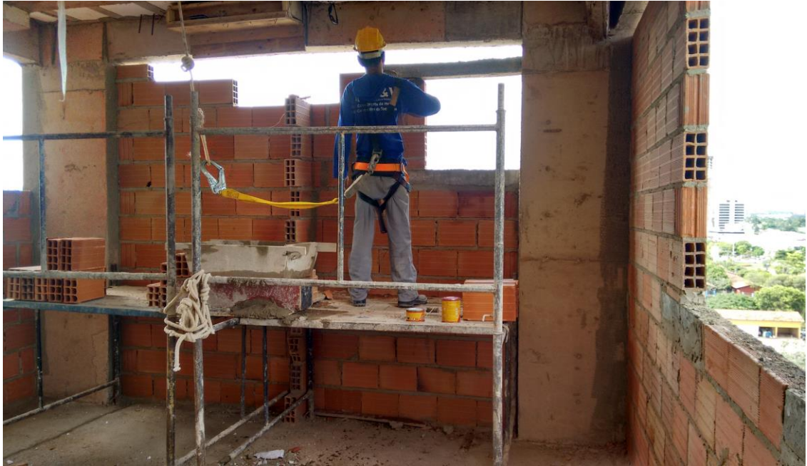
Figura 24: Colaborador finalizando execução de encunhamento
