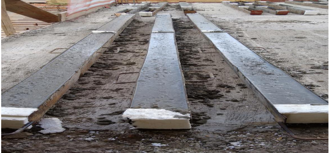
Figura 20: Produção de vergas e Contravergas
