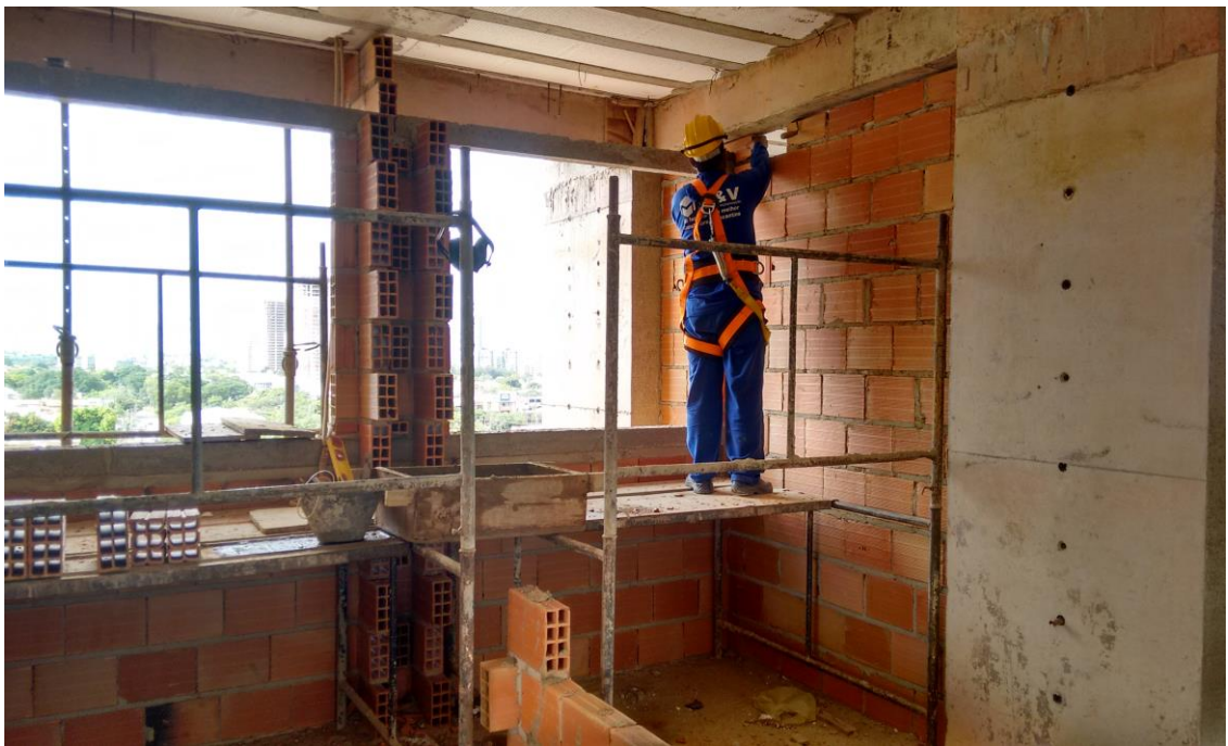
Figura 24: Colaborador finalizando execução de encunhamento
