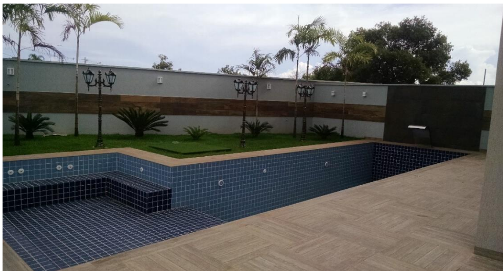
Figura 22. Revestimentos de piso e parede - piscina
