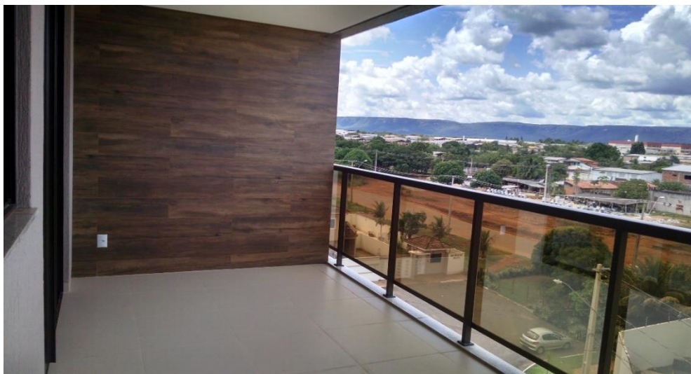
Figura 24. Revestimento de parede e guarda corpo – sacada apartamentos
