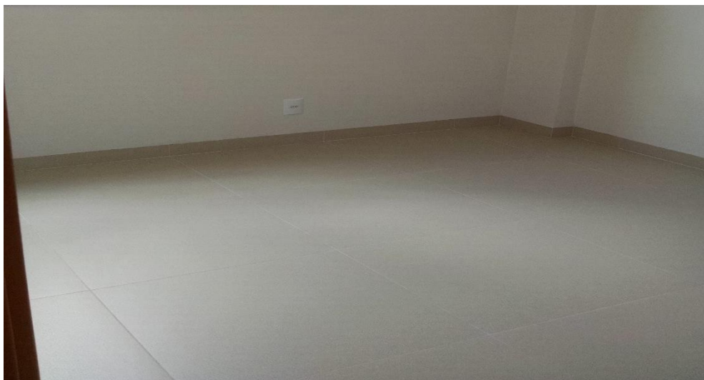
Figura 17. Revestimento de Piso - Apartamentos
