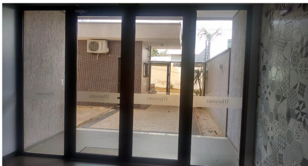
Figura 15. Portas Internas – Hall de entrada
