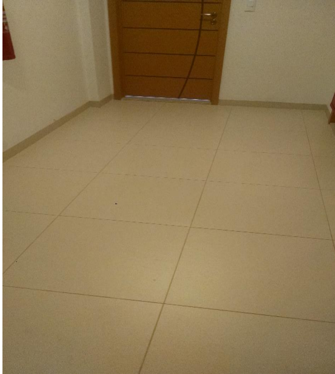
Figura 28. Revestimento de piso – Hall dos pavimentos tipo
