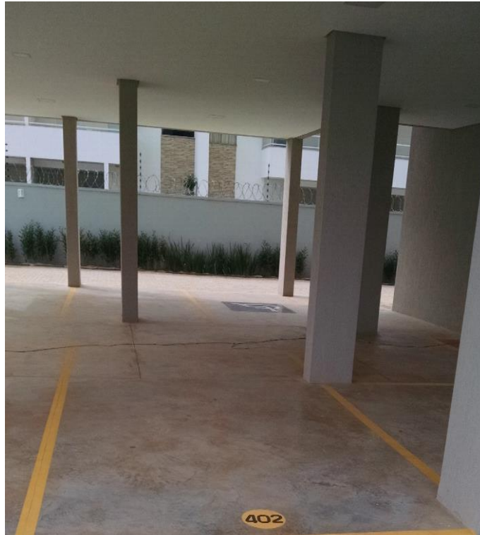
Figura 18. Revestimento de piso – garagens sob pilotis
