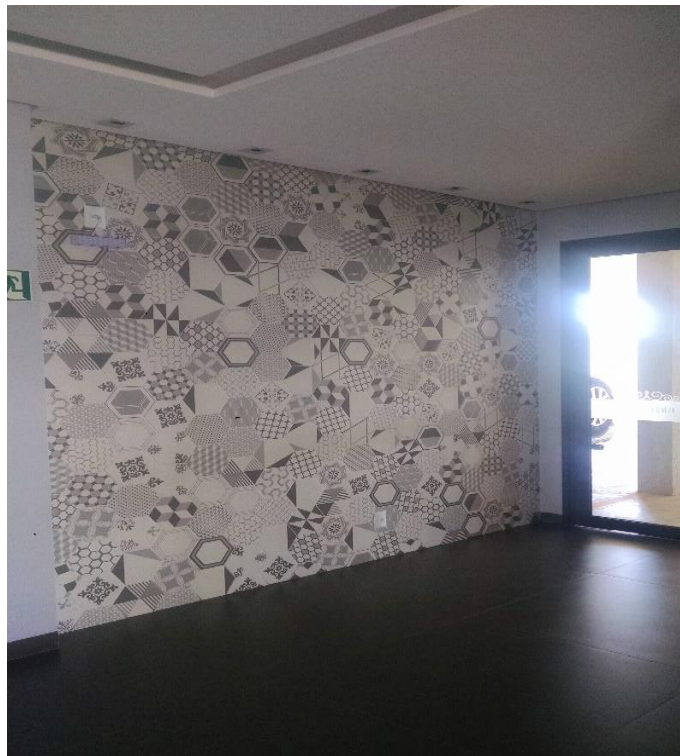
Figura 27. Revestimento de parede – Hall de entrada
