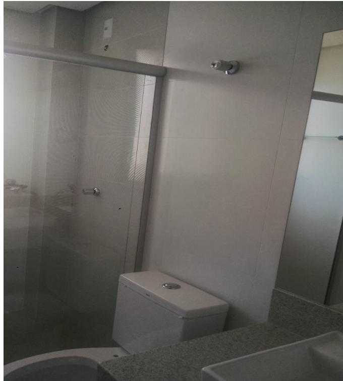
Figura 29. Revestimento parede – banheiros apartamentos
