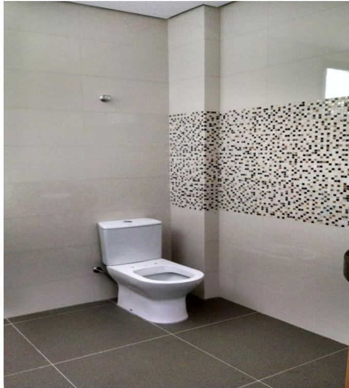
Figura 19. Banheiro PNE – Varanda Gourmet
