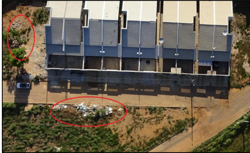
FIGURA 34. Resíduo de obra em fase de acabamento. Fonte: Autor.
