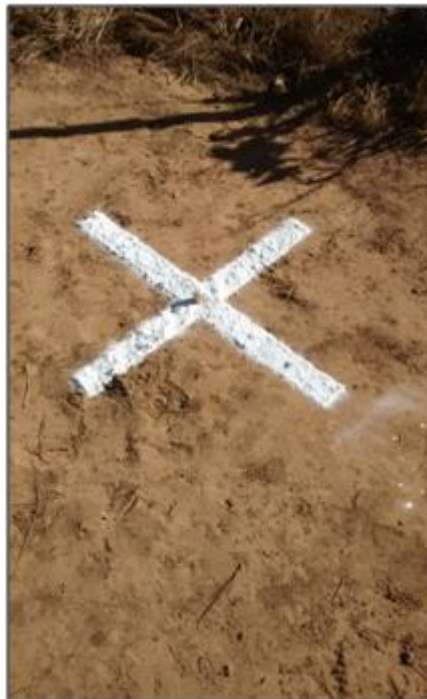
FIGURA 19. Marcação no solo com cal hidratada. Fonte: Autor.
