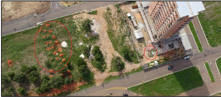
FIGURA 35. Resíduo de obra em fase de infraestruturação, escavação das fundações. Fonte: Autor.
