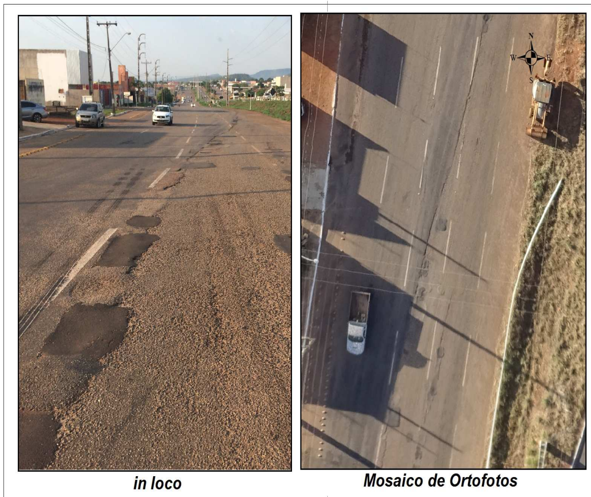
Figura 18 – Junta de serviço Fonte: (A autora)
