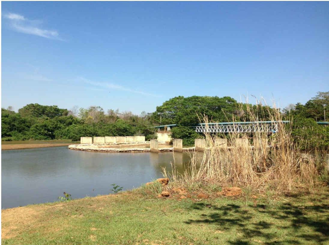
Figura 11. Barragem de nível da ETA 006
