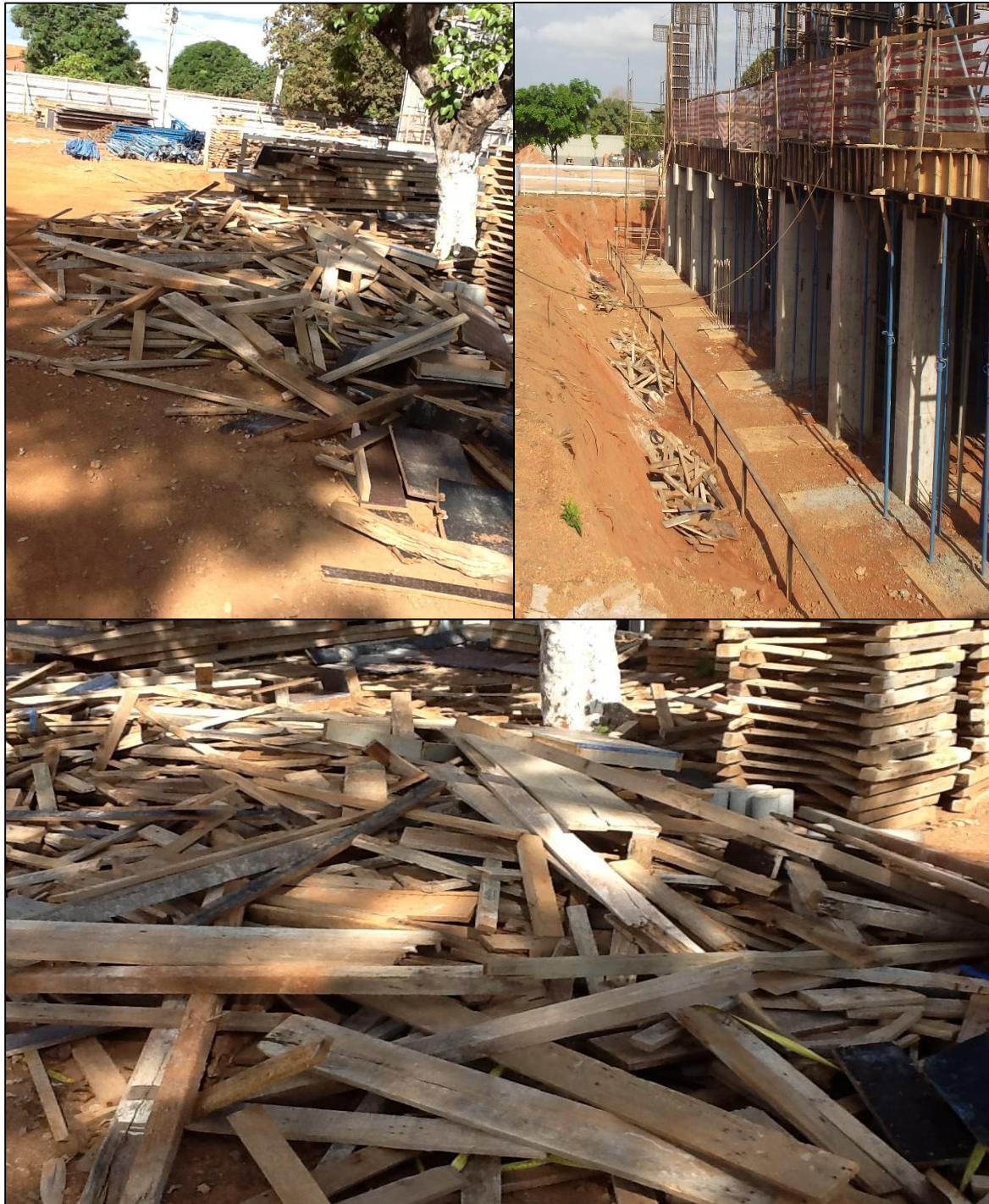
Figura 17 – Montantes de madeira próximos aos pontos de geração no canteiro
