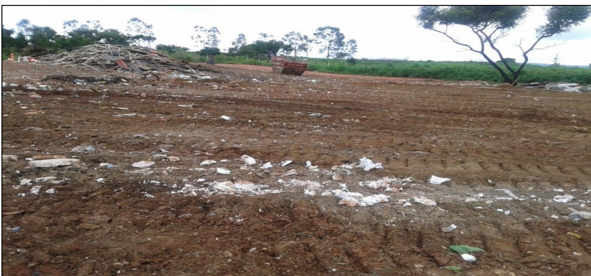
Figura 20 - Separação e Enterramento dos Resíduos para Decomposição, Exceto as Madeiras que Ficam Expostas à Natureza.
