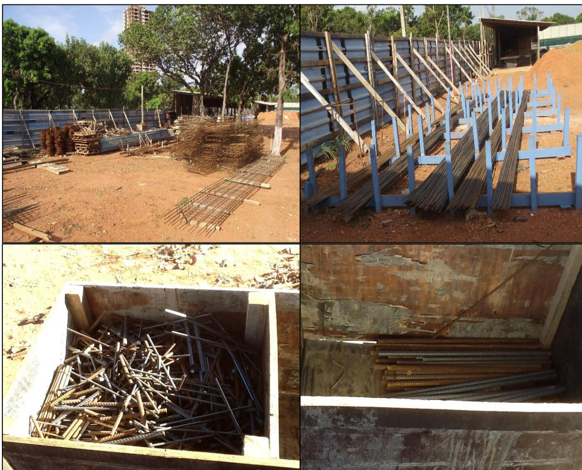
Figura 10 – Armazenamento do aço: vergalhões e corte e dobra
