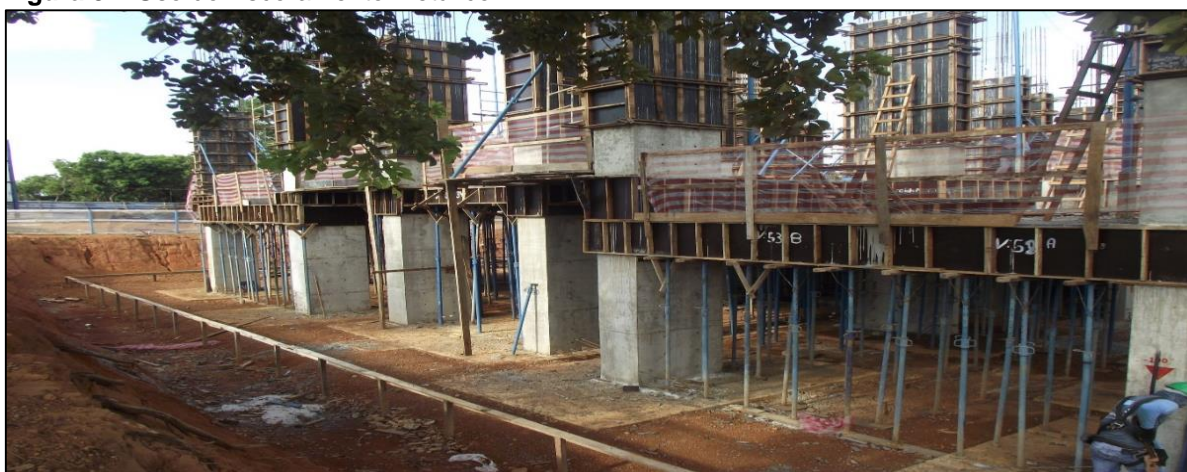
Figura 9 – Uso do Escoramento Metálico
