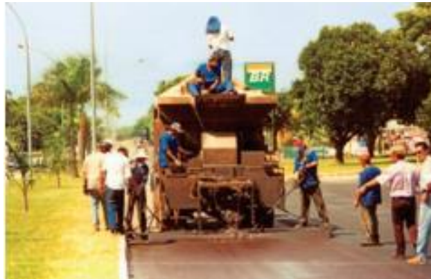
Figura 23 - Aplicação de lama asfáltica
