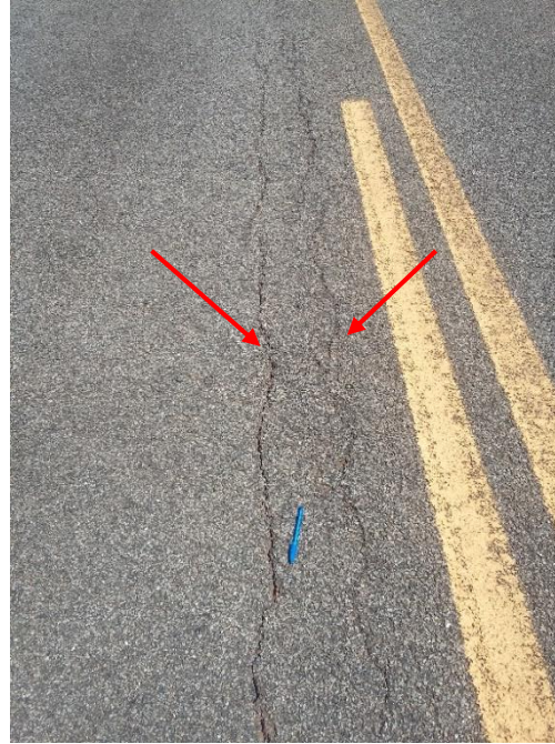
Imagem 4 - Trincas longitudinais
