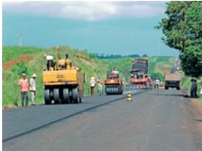
Figura 29 - Recapeamento
