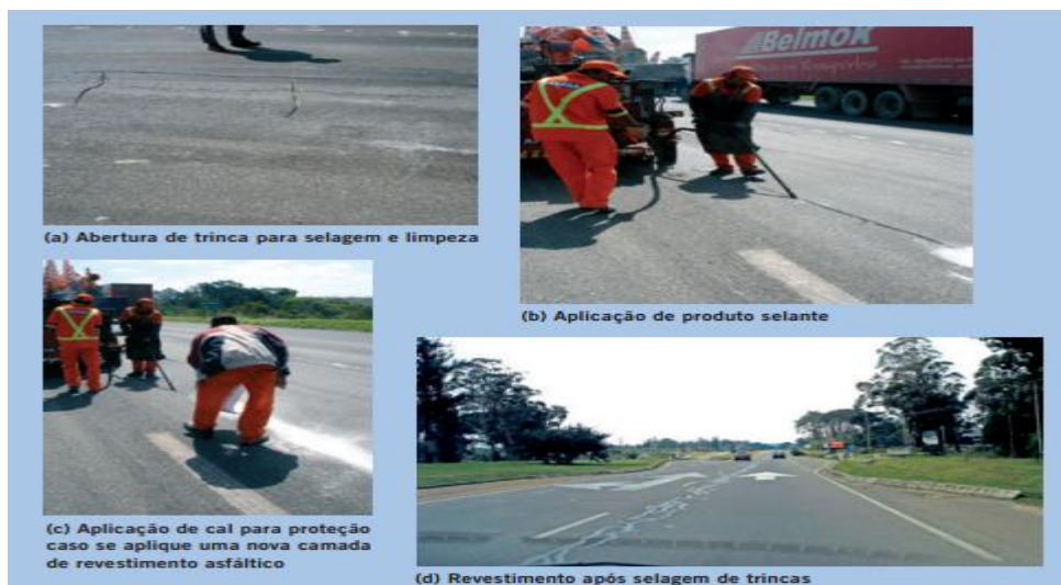
Figura 21 - Exemplo de selagem de trincas
