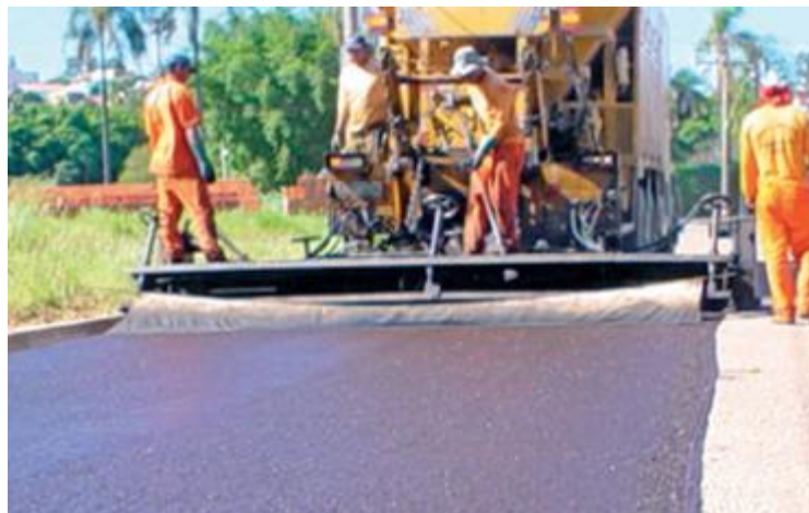
Figura 28 – Aplicação de lama asfáltica
