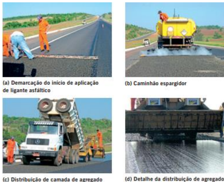
Figura 22 - Aplicação de capa selante
