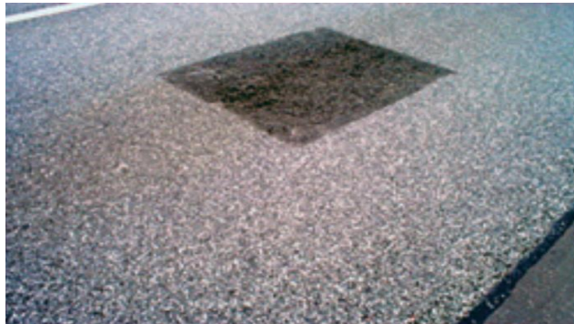
Figura 17 - Remendo
