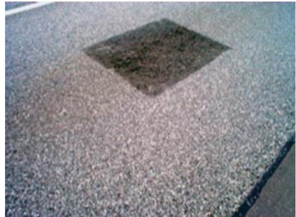
Figura 27 - Remendo bem executado
