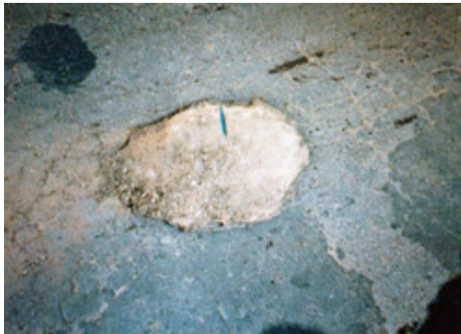
Figura 16 - Panela ou Buraco
