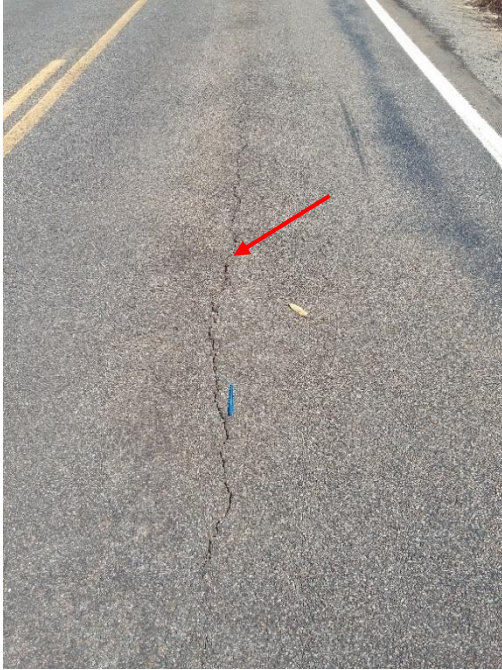
Imagem 3 - Trincas longitudinais
