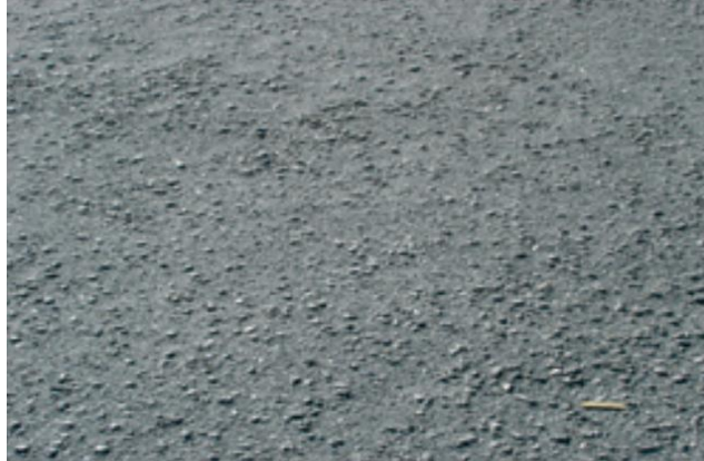
Figura 15 - Desgaste
