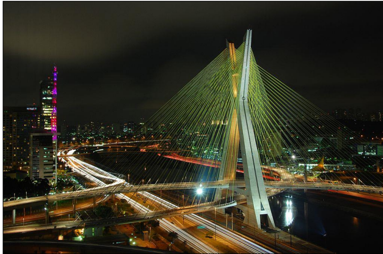
Figura 3: Ponte Octávio Frias de Oliveira
