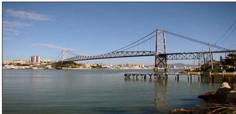
Figura 4: Ponte Hercílio Luz
